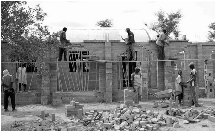
Fig. 11a e 11b Escola primária e habitações para professores construídas em BTC, na região de Dongo, no Mali. Projecto dos dinamarqueses Joop e Jurriaan van Stigt.
