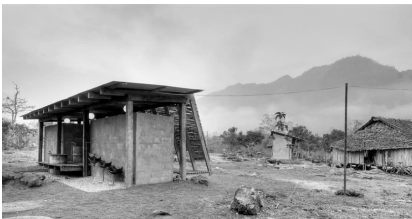
Fig. 4a e 4b Safe Haven Bathhouse, Tailândia. 2009. Esta estrutura de apoio a um orfanato, com a fachada em bambu, foi o resultado de um workshop realizado pelo gabinete TYIN tegnestue Architects, com 15 alunos noruegueses e com trabalhadores locais.
