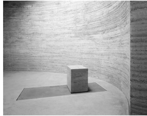
Fig. 9a e 9b Execução de uma parede de taipa pelo processo tradicional no Alto Atlas marroquino (esquerda). Capela da Reconciliação, Berlim: arquitectura contemporânea em taipa. Projecto de Rudolf Reitermann e Peter Sassenroth. (direita).
