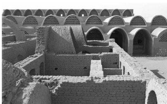
Fig. 4 Abóbadas núbias em construção (em cima).
