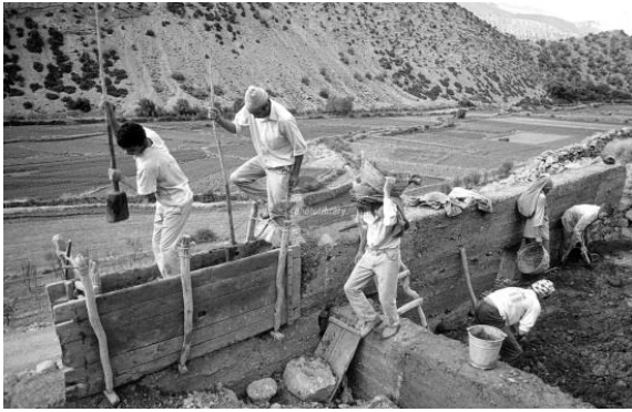
Fig. 9a e 9b Execução de uma parede de taipa pelo processo tradicional no Alto Atlas marroquino (esquerda). Capela da Reconciliação, Berlim: arquitectura contemporânea em taipa. Projecto de Rudolf Reitermann e Peter Sassenroth. (direita).
