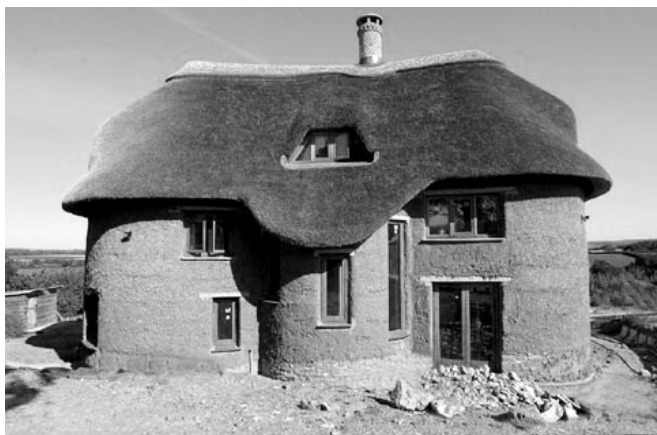
Fig. 7a e 7b Casa contemporânea em cob (esquerda). Parede em cob a ser erguida e moldada com as mãos (direita). O cob é uma técnica que se presta mais à criação de formas orgânicas do que de formas retilíneas, contrariamente a técnicas como a taipa ou o BTC.
