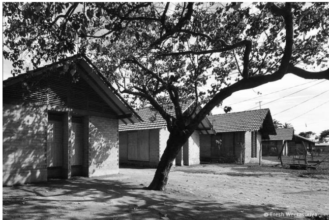
Fig. 13a e 13b Projecto de reconstrução para Kirinda, Sri Lanka, após o tsunami de 2004, pelo arquitecto Shigeru Ban. As casas foram construídas em BTC, material disponível a baixo preço no país e que não exige mão-de-obra especializada.
