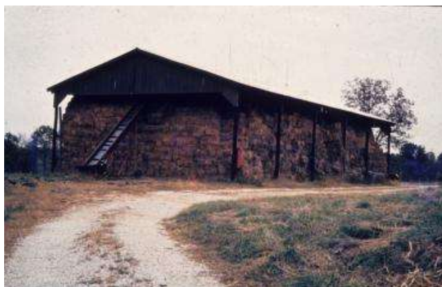
Fig nº 34 - Fenil apenas coberto no topo e no lado de vento e chuva dominantes
