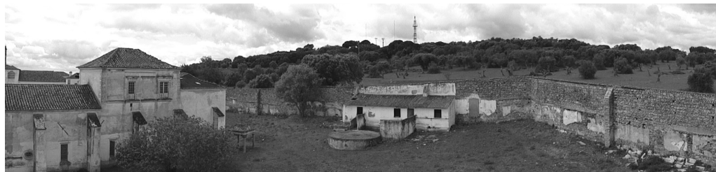
Fig. 17. Vista do pátio da lavagem
