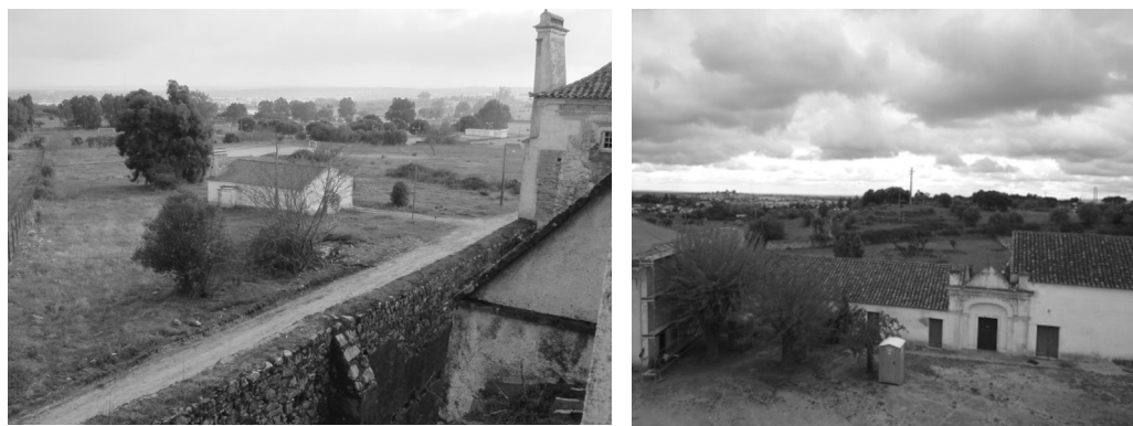
Figs. 39 e 40. Vistas da cerca do Mosteiro e do acesso à horta
