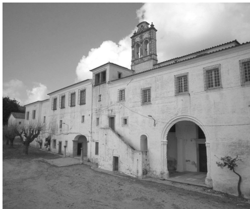
Fig. 2. Vista do alçado sul do mosteiro de S. Bento de Cástris
