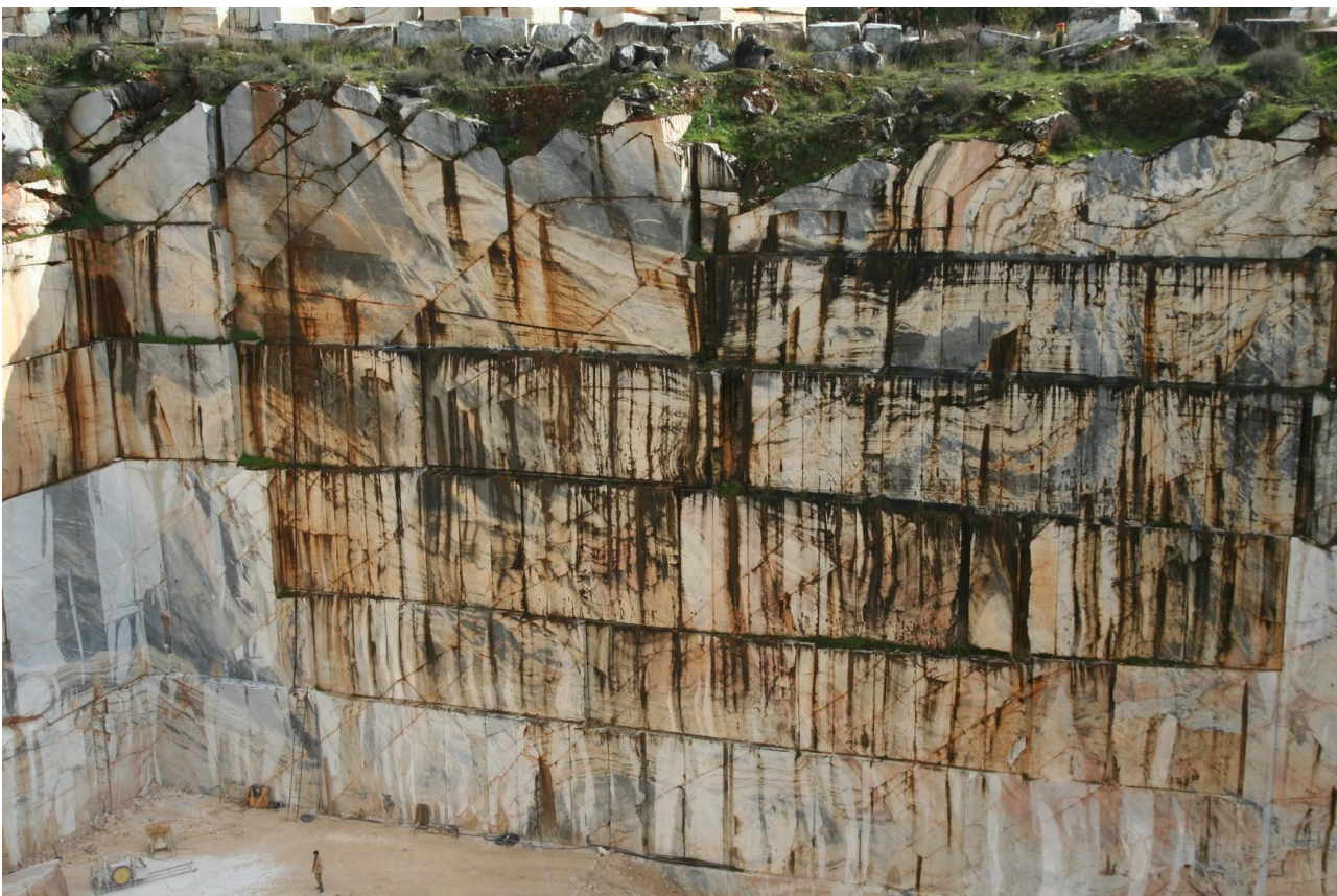
Fig. 5 – Padrões de interferência entre as duas fases de deformação dúctil que afectaram o anticlinal de Estremoz. Frente de desmorte da pedreira da empresa A. Mocho, Lda., Lagoa, flanco SW do anticlinal de Estremoz, em 17 de Fevereiro de 2010.
