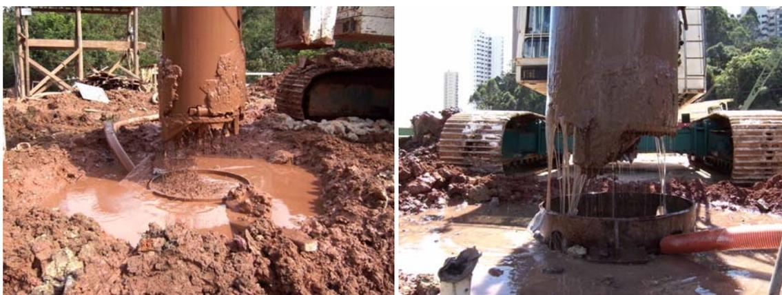
Figura 1. Escavação de estaca moldada: (A) com bentonite; (B) com polímero.
