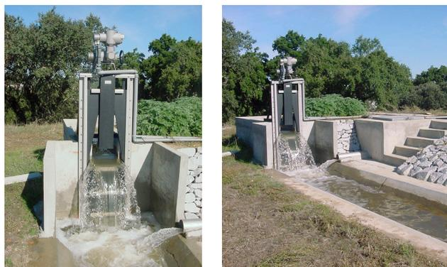
Figura 2 – Comporta tipo descarregador de altura ajustável (overshot gate).
