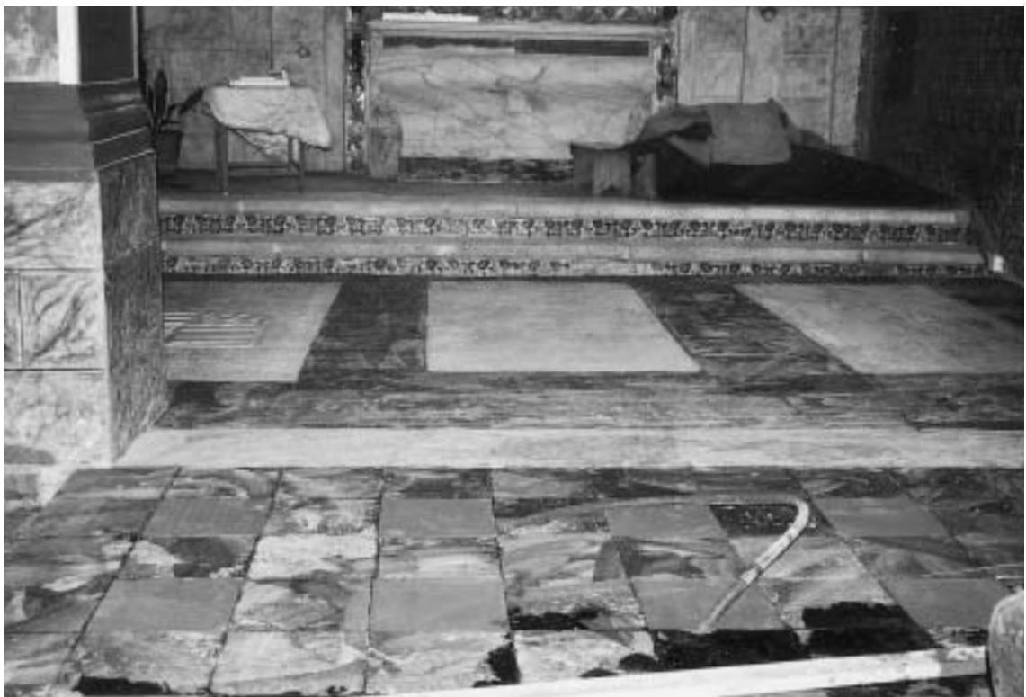
Figs. 16 e 17 Aspecto final do pavimento na nave central e altar principal.
