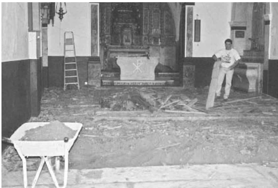
Fig. 5 Remoção do pavimento de madeira.
