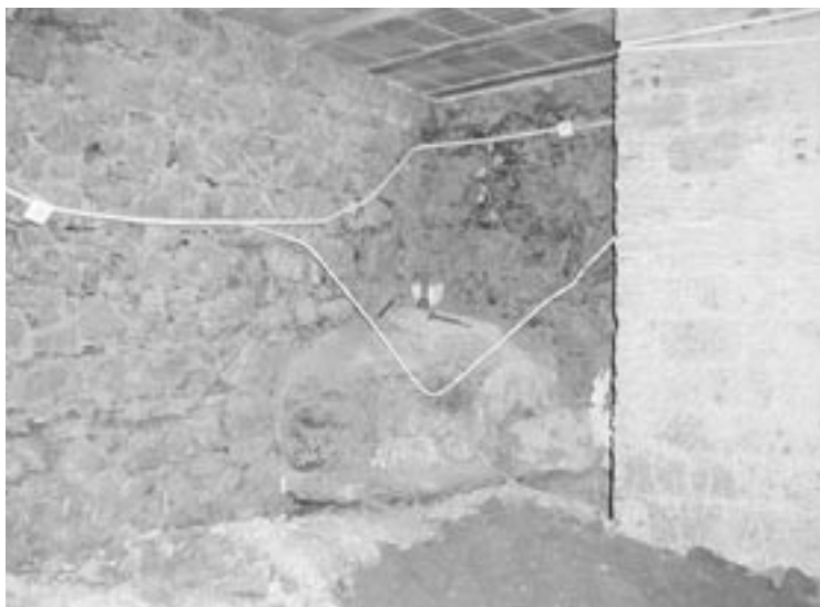
Fig. 7 Pormenor da obra do Ambiente 1.
