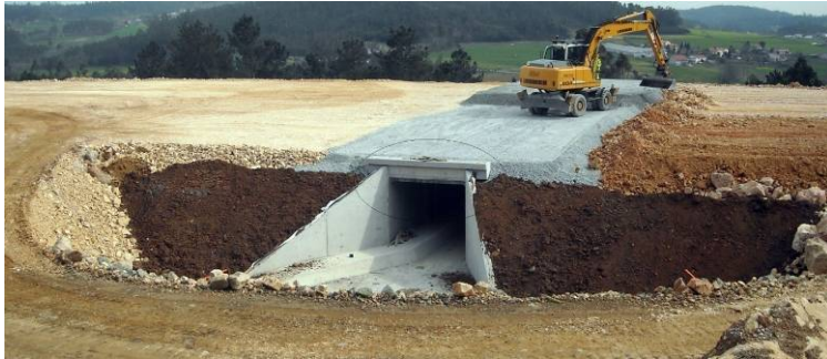
Figura 2.23: Obra de drenaxe transversal (ODT)
