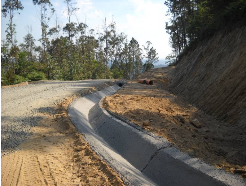
Figura 2.6: Exemplo de cuneta triangular revestida
