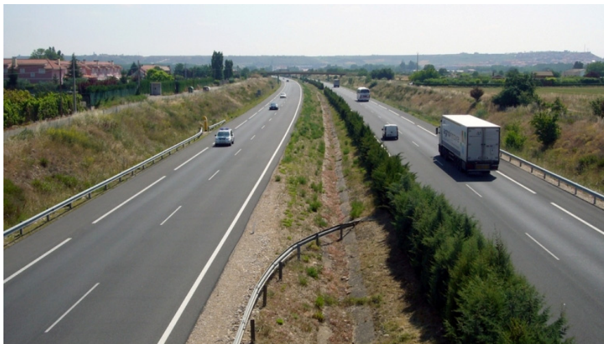
Figura 2.17: Cuneta de mediana en calzadas separadas
