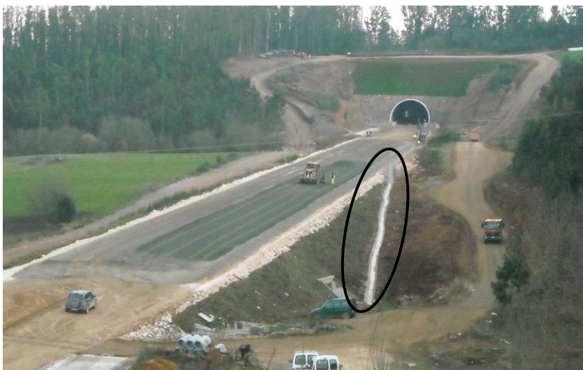
Figura 2.22: Cuneta de pé de terraplén con saída cara unha obra de drenaxe transversal
