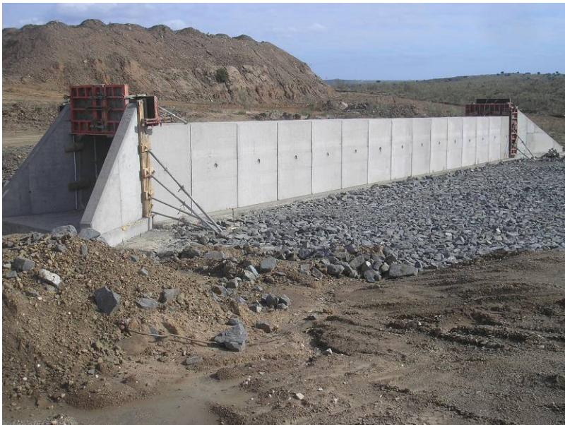
Figura 3.4: Manto drenante debaixo dunha ODT
