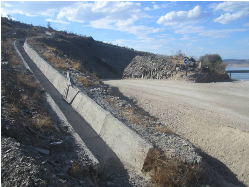
Figura 2.20: Cuneta de garda de desmorte
