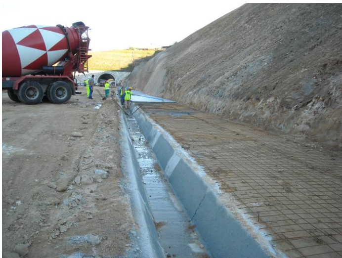
Figura 2.19: Cuneta de pé de desmonte
