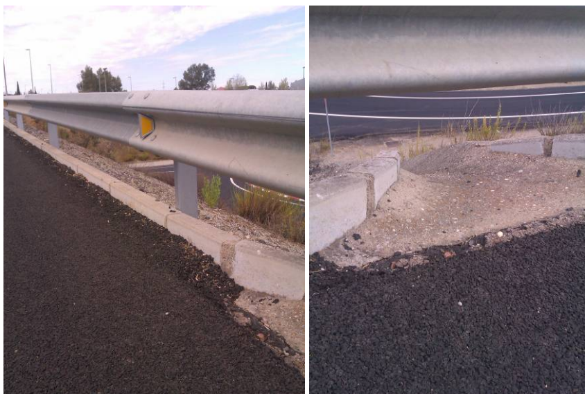
Figura 2.21: Canle de derivación de coroación de terraplén e baixante pola que desauga
