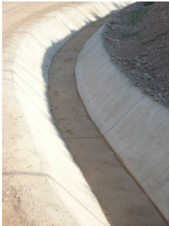
Figura 2.8: Cuneta trapezoidal revestida
