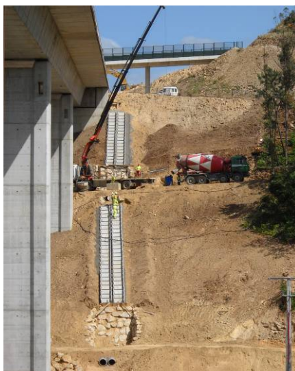
Figura 2.16: Baixante situada na ladeira dun viaduto
