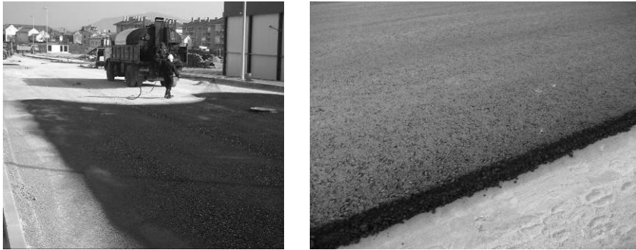
Figura 4.2: Rego de adherencia (esquerda) e mestura bituminosa (dereita)
