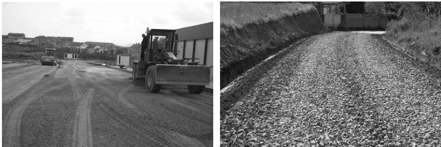
Figura 4.1: Capas granulares: balastro (esquerda) e macádam (dereita)
