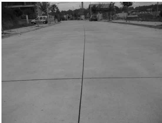
Figura 5.5: Firme ríxido con pavimento de formigón
