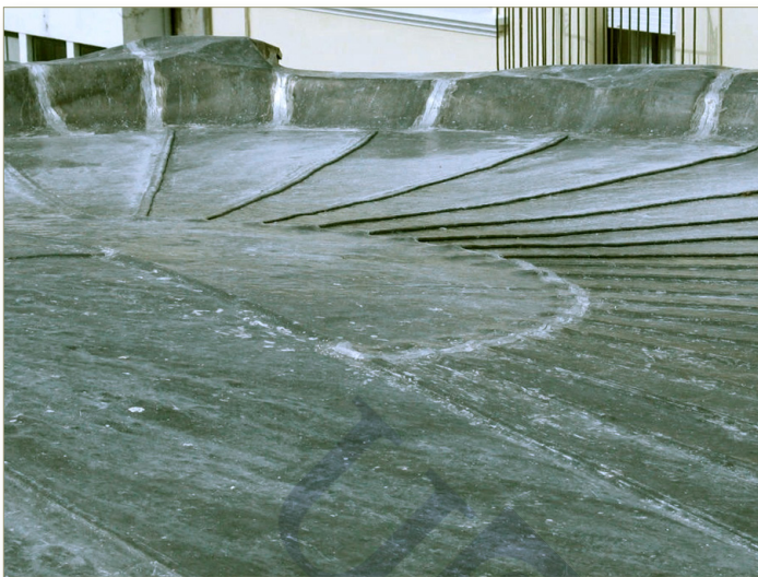
Figura 41. Vista parcial del emplomado dispuesto en forma radial.
