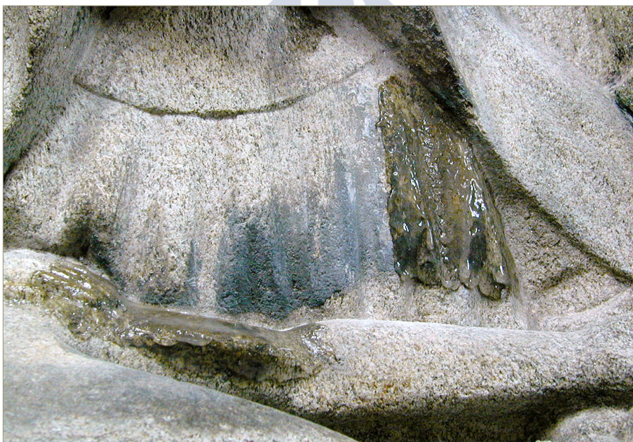
Figura 42. Vista del gel aplicado para la eliminación de la costra negra
