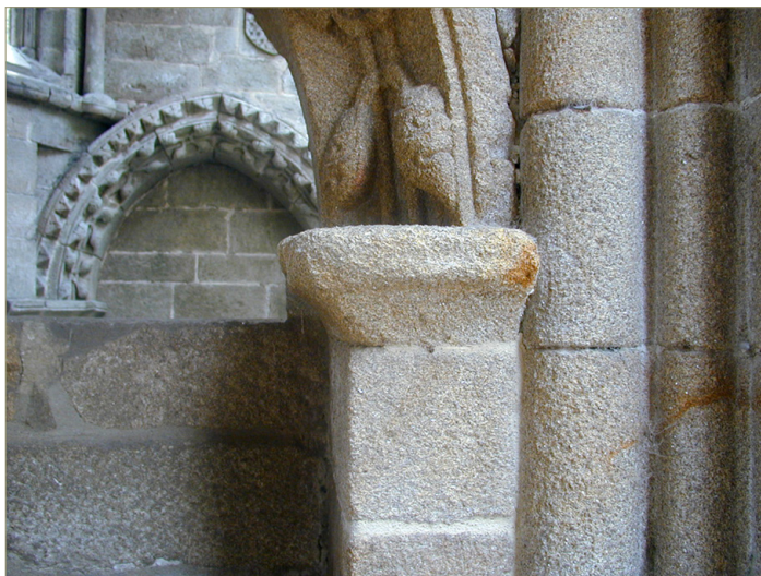
Figura 1. Capilla 4. Detalle de la ménsula derecha y arquivolta del arco que comunica esta capilla con la capilla 3. Se observa la presencia en la roca de bandeados de oxidación, típicos de las rocas graníticas prehercínicas gallegas. También se puede observar la intensa pérdida de relieve por arenización
