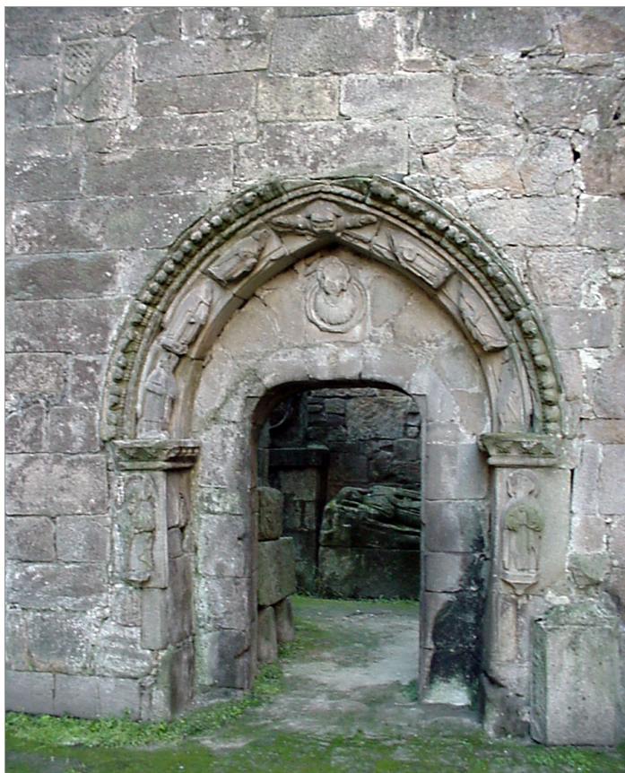
Figura 13. Hastial sur: la portada oriental –a la izquierda mirando al muro– es considerada por Carmen Manso como el antiguo arcosolio del enterramiento de don Suero Gómez de Sotomayor, si bien reformado en el siglo XVII como arco de acceso a la capilla de San Jacinto –que ocupó el lugar de la antigua sacristía–
