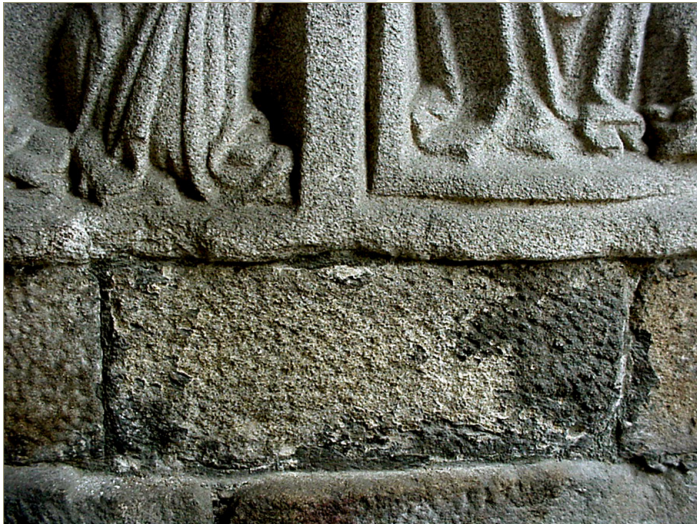
Figura 4. Capilla 2. Aspecto de las costras negras que afectan al monumento, en este caso, en los sillares del paño bajo el tímpano de la Epifanía, en donde la costra está asociada con separaciones superficiales
