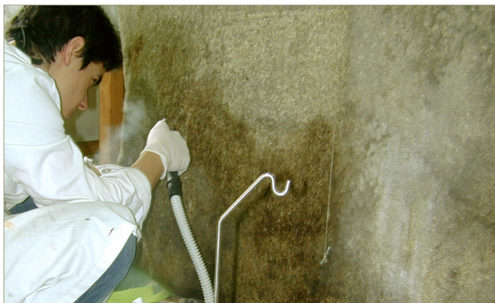
Figura 40. Limpieza en húmedo con chorro de vapor
