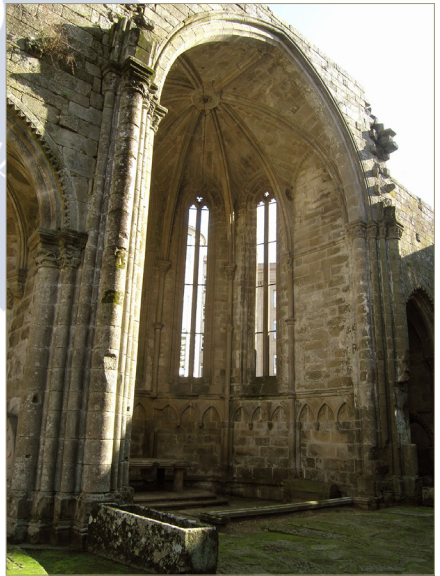
Figura 5. Vista del arco apuntado que da acceso a la Capilla Mayor
