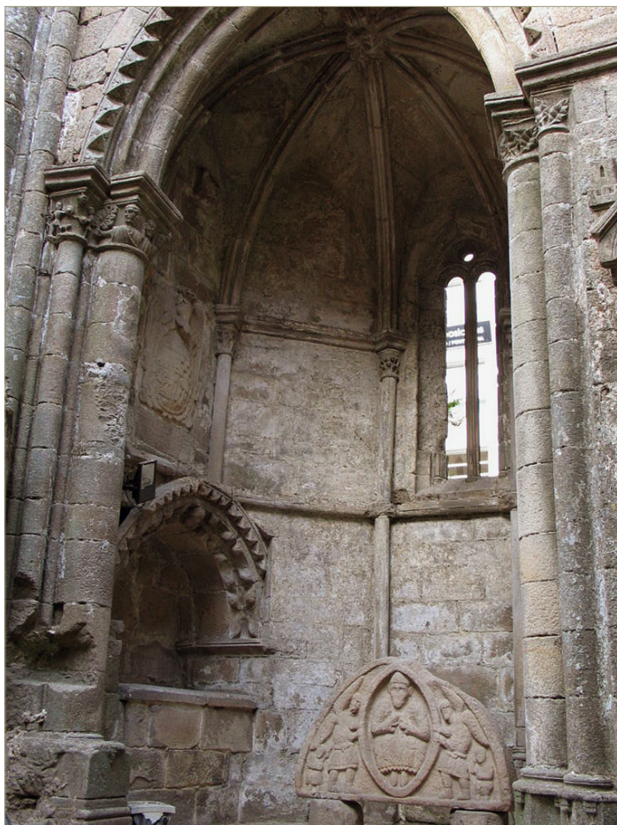
Figura 9. Vista de la primera capilla absidal del lado de la Epístola. La estructura de las bóvedas sigue el mismo esquema que el de las capillas del lado del Evangelio
