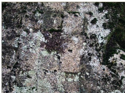
Figura 37. Los colores blancos y verde claros se corresponden con líquenes, que en este escudo, ocupan más superficie que los musgos
