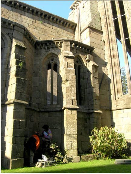
Figura 18. Vista exterior: escalonamiento de las caras frontales de los estribos de las capillas de la Epístola
