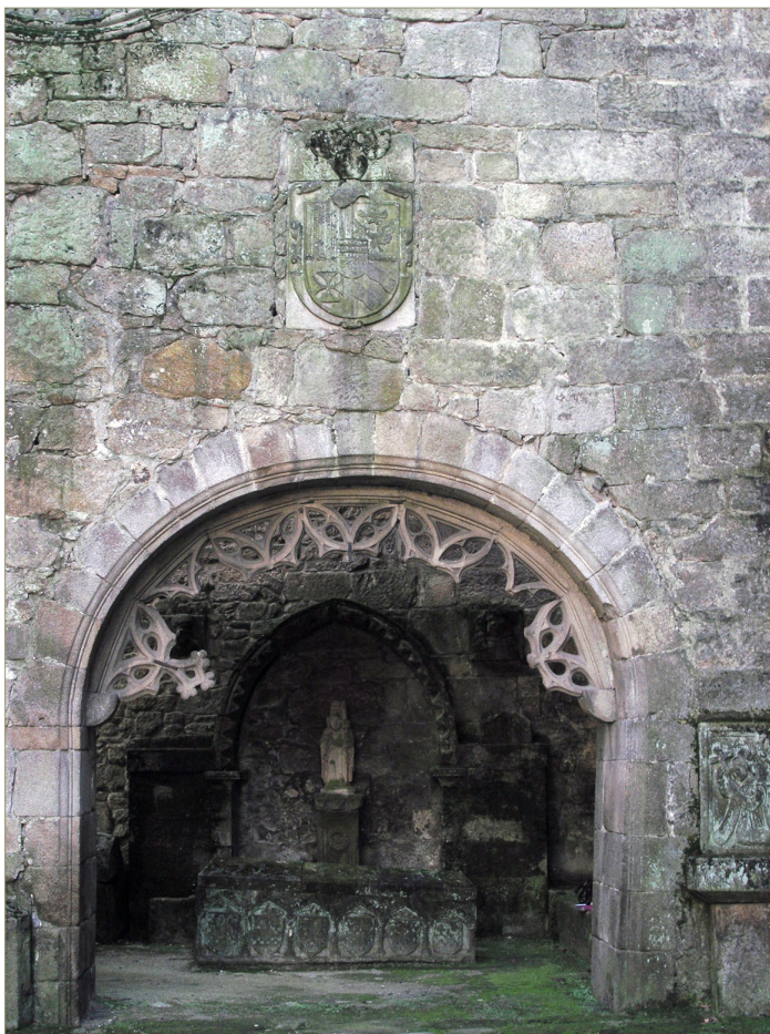
Figura 14. La portada occidental –a la derecha mirando al muro- daba paso a la “nueva” sacristía del siglo XVI. Su intradós con fina tracería calada proviene de la iglesia de Santa María, también en Pontevedra
