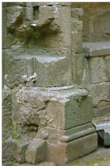
Figura 15. Ejemplo de un primer tipo de basamento de sección cuadrangular
