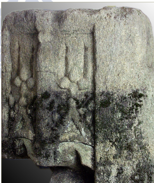
Figura 39. Limpieza en seco de la mitad de uno de los remates externos
