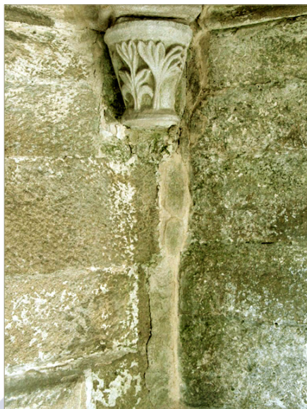
Figura 20. Uno de los capiteles de sección tronco-cónica. No conserva la columnilla sobre la que descansaba
