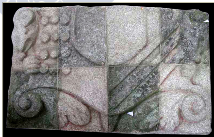
Figura 21. Vista de la limpieza en seco de la parte inferior; se trabaja en cuadrículas para controlar en todo momento el grado de limpieza y para documentar el proceso
