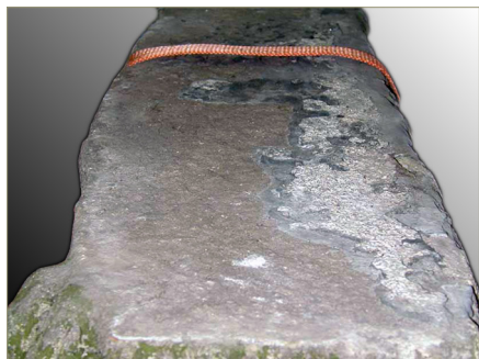
Figura 19. Vista de una de las uniones de los fragmentos con restos de cemento y piedra desprendida en la parte derecha de la imagen
