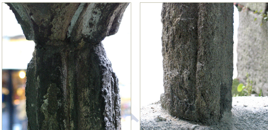
Figuras 6 y 7. Detalles de la superficie afectada por arenización y costra negra del fuste del parteluz izquierdo de la capilla 1. Se puede observar la espectacular pérdida de relieve provocada por estos tipos de deterioro
