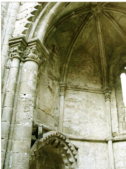
Figura 19. Vista de los distintos tipos de desbastado de los capiteles de la cabecera
