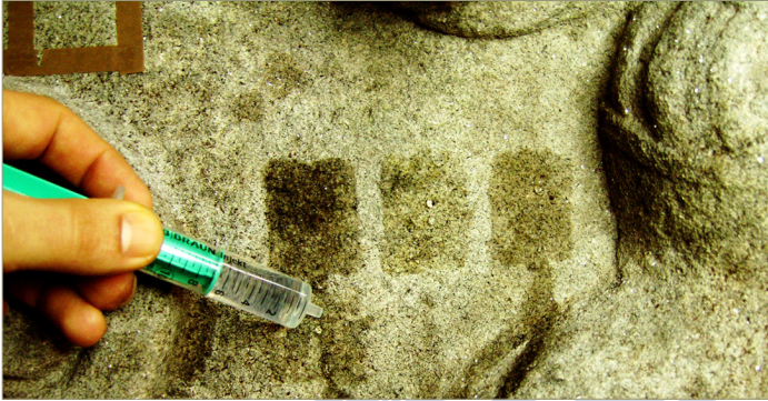
Figura 7. Pruebas con distintos productos hidrofugantes y en distintas concentraciones
