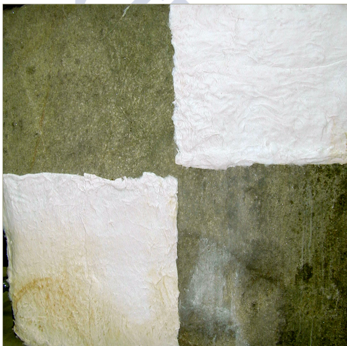
Figura 41. Aplicación por cuartos de emplastes con productos biocidas
