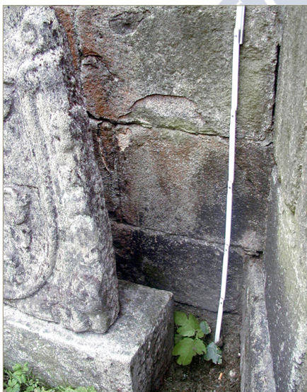
Figura 9 y 10. Aspecto de las separaciones superficiales que se desarrollan en el paño exterior del edificio (izquierda) y en el interior de la capilla 1 (derecha). Las separaciones superficiales afectan principalmente a los muros hasta 1,5 - 2 m de altura
