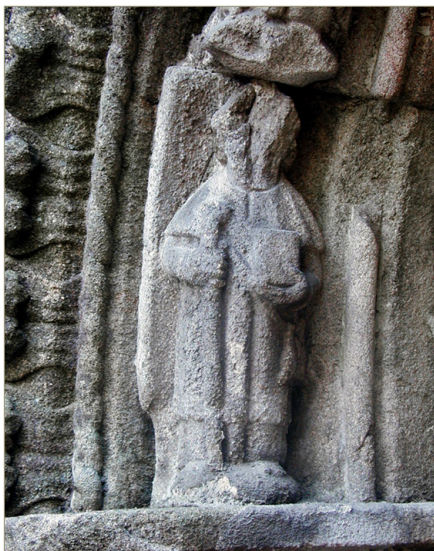
Figura 8. En la imagen se puede apreciar una de las figuras que forman la arquivolta del arco de la puerta izquierda bajo el rosetón, con mutilaciones y fuerte desagregación arenosa
