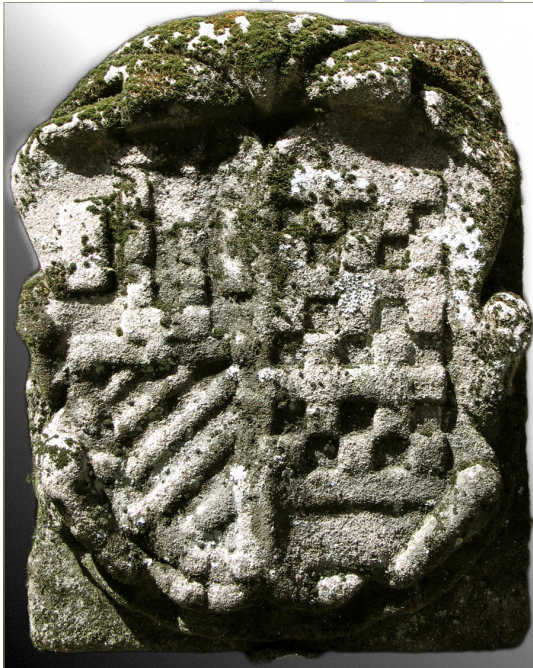
Figura 35. Vista general del Escudo nº 5. Está intensamente colonizado por líquenes debido a que la zona en que se halla es una de las más soleadas del recinto
