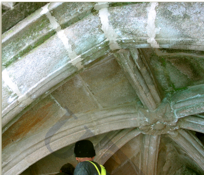
Figura 43. Vista de los nuevos morteros de juntas en una de las capillas.
