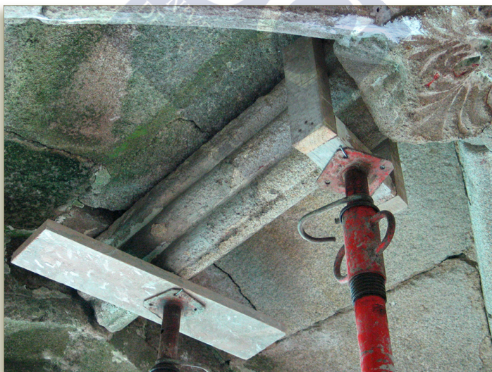
Figura 44. Las nervaduras de una de las bóvedas se aseguran durante la intervención arquitectónica. Próximo a la clave, se aprecia un "testigo" de mortero para verificar posibles desplazamientos en las estructuras.
