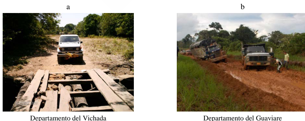
Figura 4. 18. Estado de las vías en la región de la Orinoquia. Periodo de observación: 2005-2008
