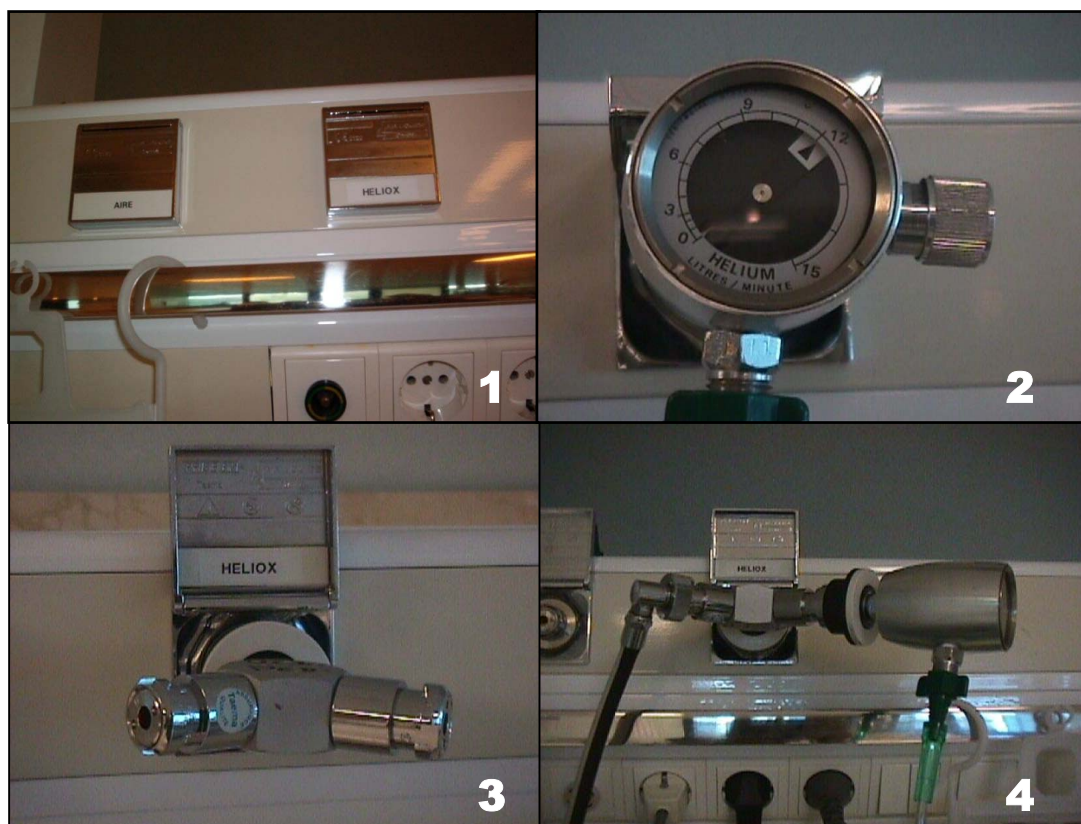
Figura 14.- Conectividad a pie de cama del sistema centralizado de HELIOX de la Unidad de Cuidados Intensivos Pediátricos del Hospital Clínico Universitario de Santiago de Compostela:
