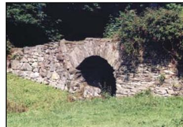
Observaciones: Se aprecian varias reparaciones y reformas en su obra de fábrica. Quizás la más importante, en cuanto cambia totalmente la estructura del puente, es la que afecta al propio arco ya que éste, aguas arriba, presenta un dovelaje de sillares de granito a hueso de medio punto mientras que aguas abajo el arco es rebajado y construido de losas.
