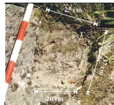
Lam. 11. Ponte do Román. Detalle del rebaje en la parte superior de una de sus pilas.
