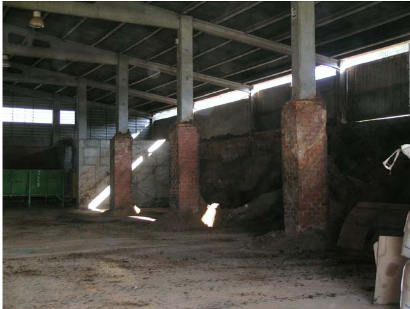
Figura 6 Zona de recepción y almacenaje del estiércol de pollo
