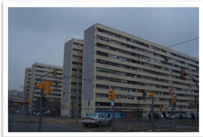
Vista del barrio de La Mina
