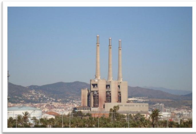
Vista de las tres torres de la central térmica de Sant Adrià Besòs
