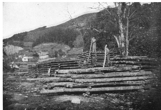
Fig. 1. 16. Troncos amoreados para secar (Montero et al. 2007).
