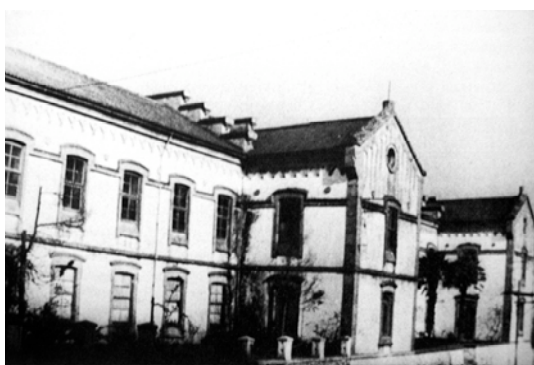
Fig. 8. Edificio construido para el asilo de las Mercedes de Lugo.
