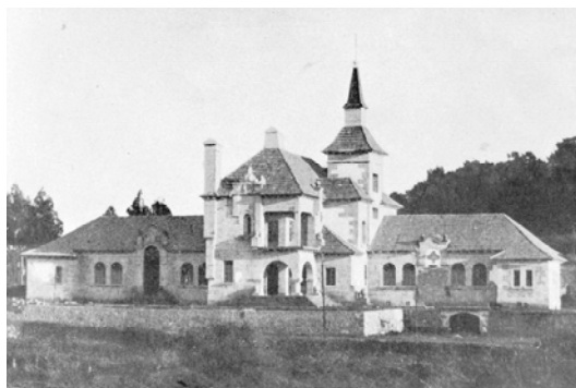
Fig. 20. Asilo de A Guarda.
