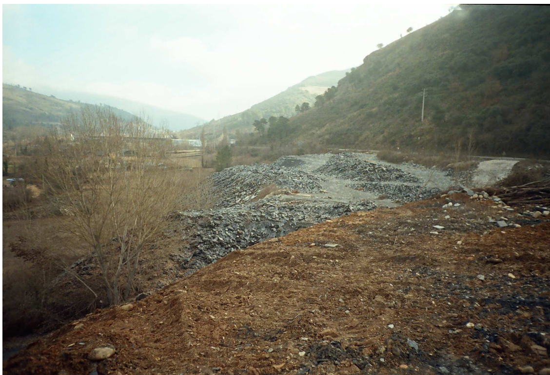
Figura 128. Entulleiras de lousa cubertas de solo importado, en primeiro termo, e sen restaurar, en segundo termo (entulleira de ANPEAL, O Barco de Valdeorras).
