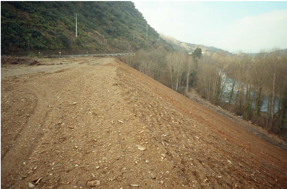
Figura 29. Entulleira de lousa cuberta de solo importado, na marxe esquerda do río Sil (O Barco de Valdeorras, Ourense). Nótase a situación da entulleira practicamente dentro do mesmo leito do río.
