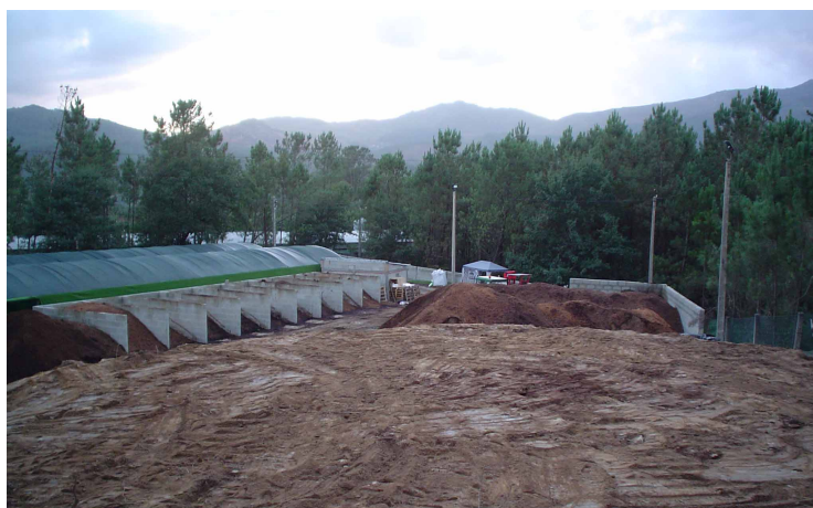
Figura 38. Vista da parte exterior das instalacións de Ecocelta (Ponteareas), na que se observan as parcelas de formigón onde se realiza a compostaxe. Fotografía: S. Quiroga.
