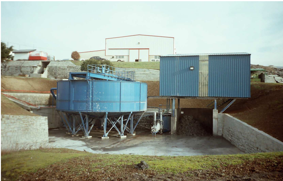
Figura 74. Instalación para a decantación de lodos no Trigal (Carballeda de Valdeorras). De dereita a esquerda: filtro prensa, decantador e balsa.
