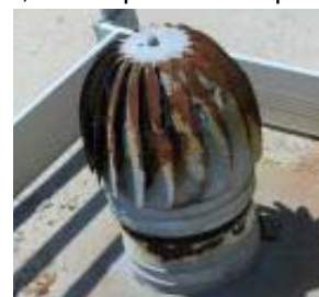
Figura 1.1. Corrosión por H_2S
