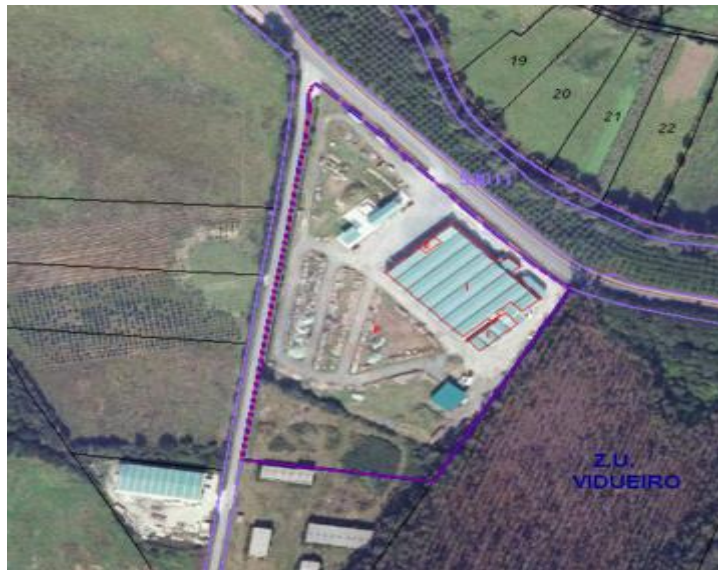
Imagen 1. Vista aérea de la nave.
