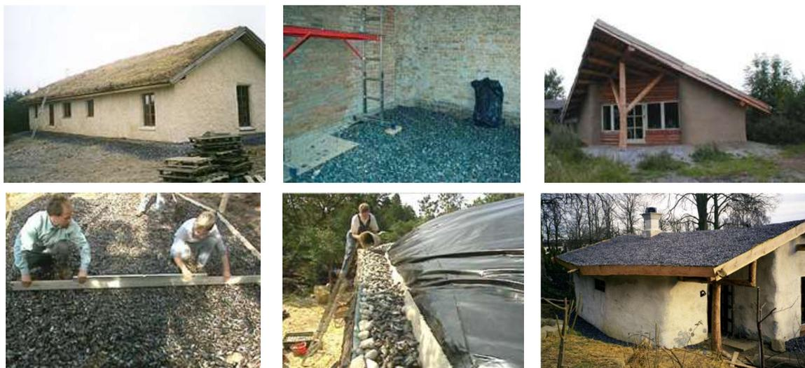
*Figura 11. Diferentes construcciones danesas con concha de mejillón (cimentación y cubierta). (40)*
