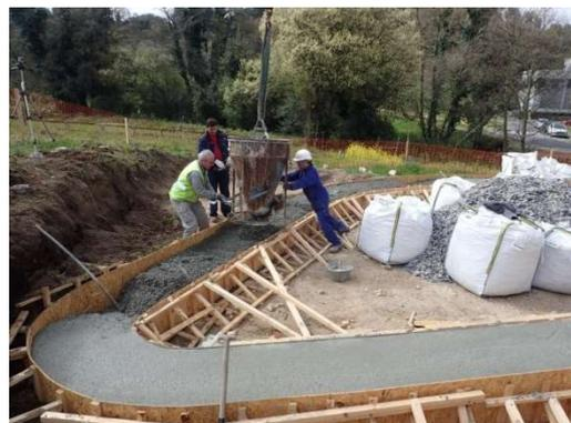
Vertido y extendido del hormigón en masa de la zapata corrida.
