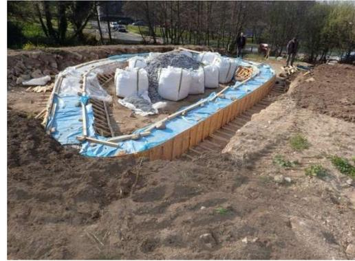
Curado del hormigón. Inicio del desencofrado y movimiento de tierras perimetral.
