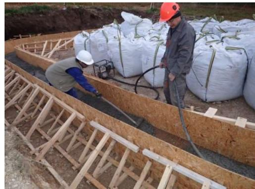
Extendido y vibrado del hormigón de limpieza
