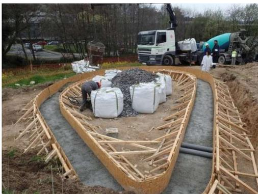
Curado del hormigón de limpieza. Colocación de tubos para instalaciones.
