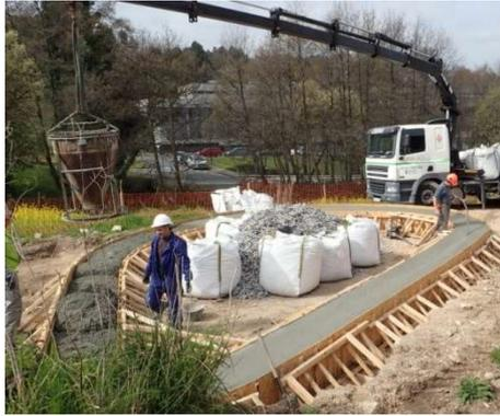
Vibrado del hormigón en masa con áridos de mejillón.
