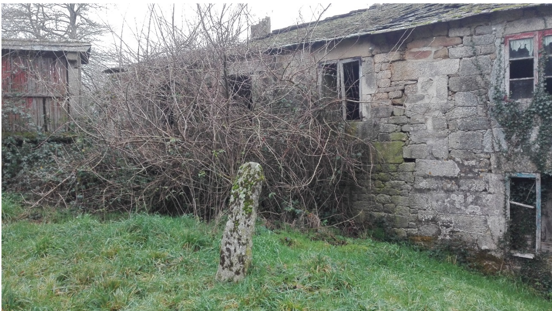
ILUSTRACIÓN 8. FACHADA SUR VIVIENDAS 2.
