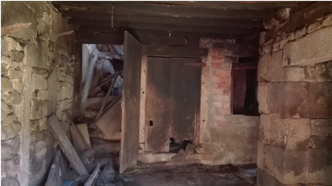
ILUSTRACIÓN 12. INTERIOR VIVIENDA B 3.
