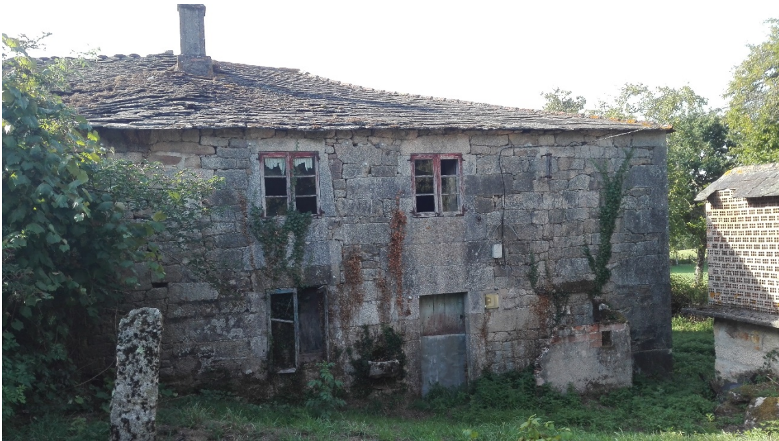
ILUSTRACIÓN 7. FACHADA SUR VIVIENDAS.
