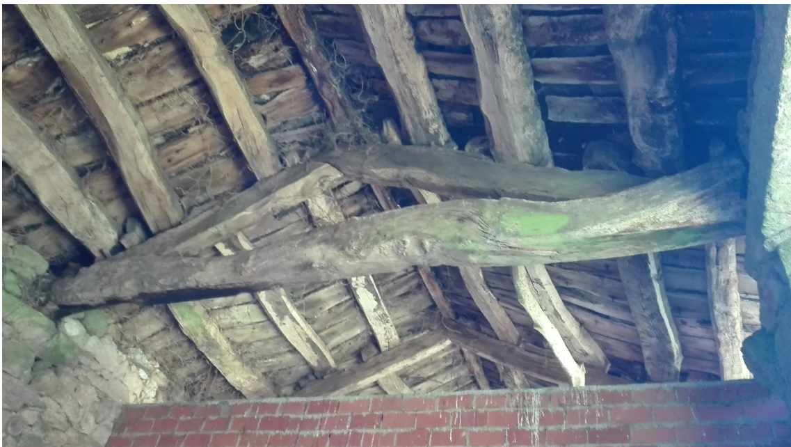
ILUSTRACIÓN 21. ESTRUCTURA DE LA CUBIERTA DEL ALPENDRE.
