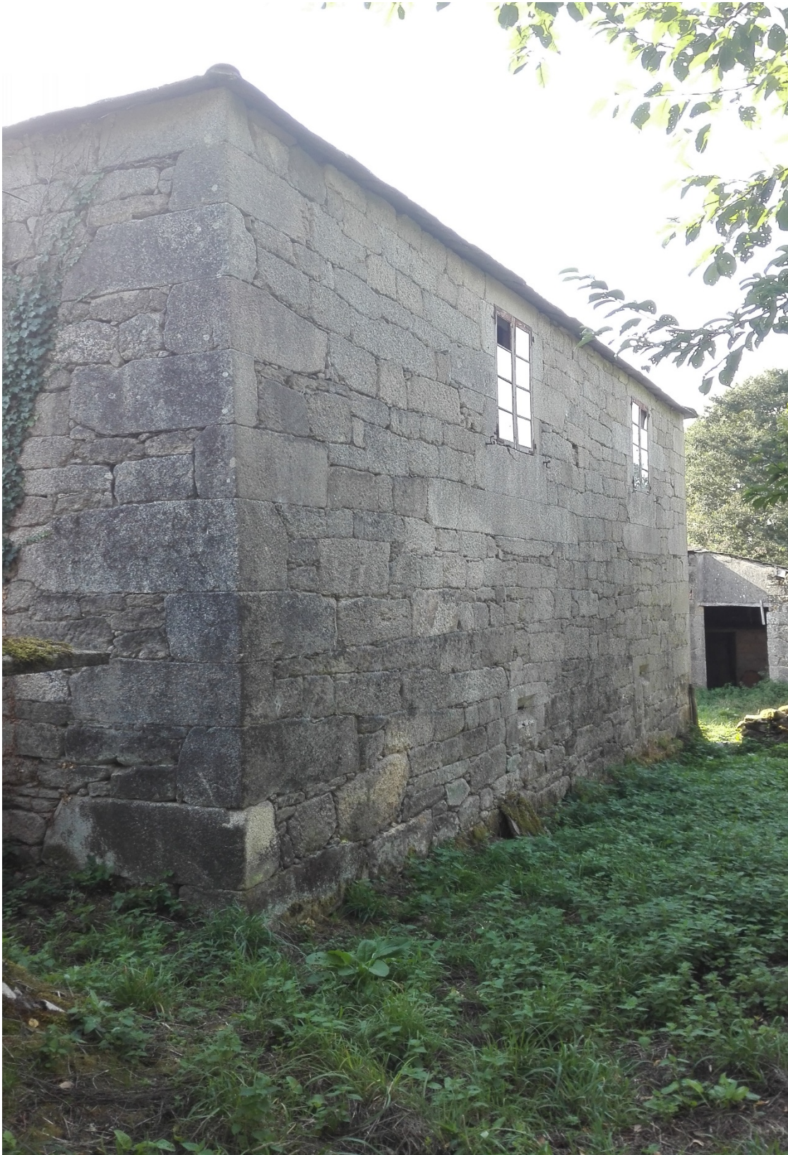
ILUSTRACION 9. FACHADA ESTE VIVIENDAS.
