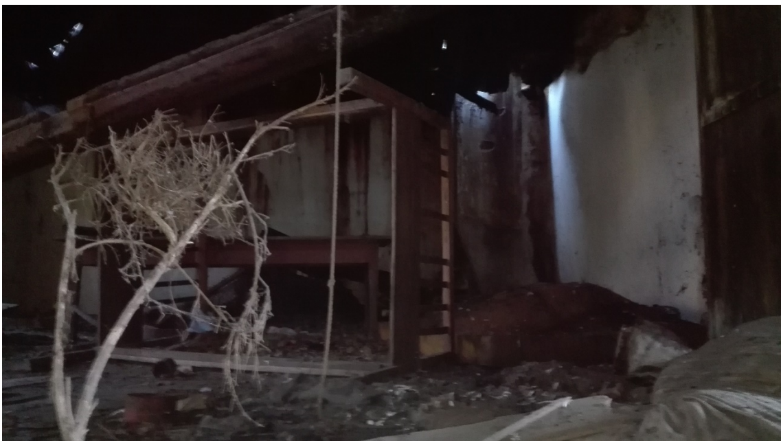
ILUSTRACIÓN 15. INTERIOR VIVIENDA B PLANTA PRIMERA 2.
