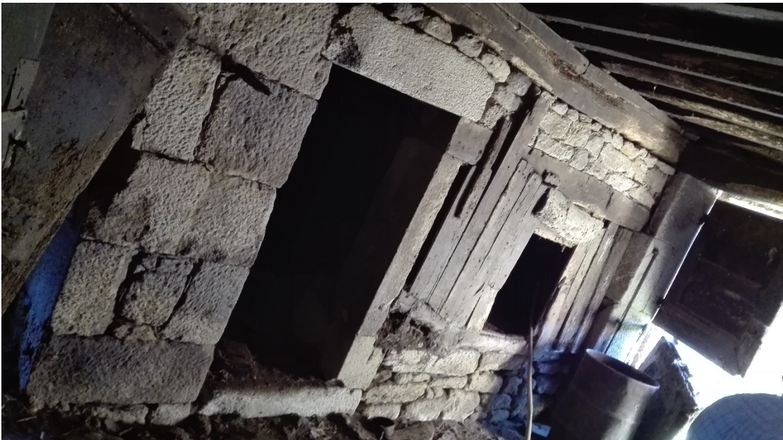
ILUSTRACIÓN 11. INTERIOR VIVIENDA B 2.
