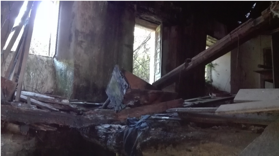
ILUSTRACIÓN 14. INTERIOR VIVIENDA B, PLANTA PRIMERA.
