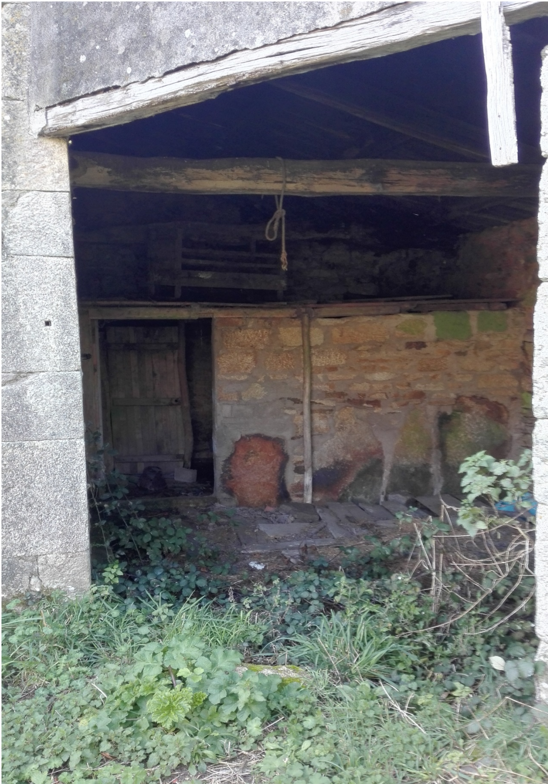
ILUSTRACIÓN 18. INTERIOR ALPENDRES FACHADA ESTE.
