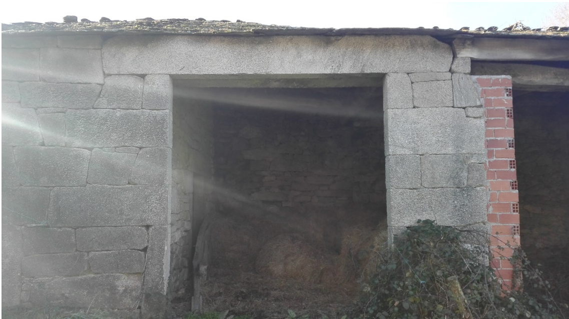
INTERIOR ALPENDRE FRONTAL A LA VIVIENDA B.
