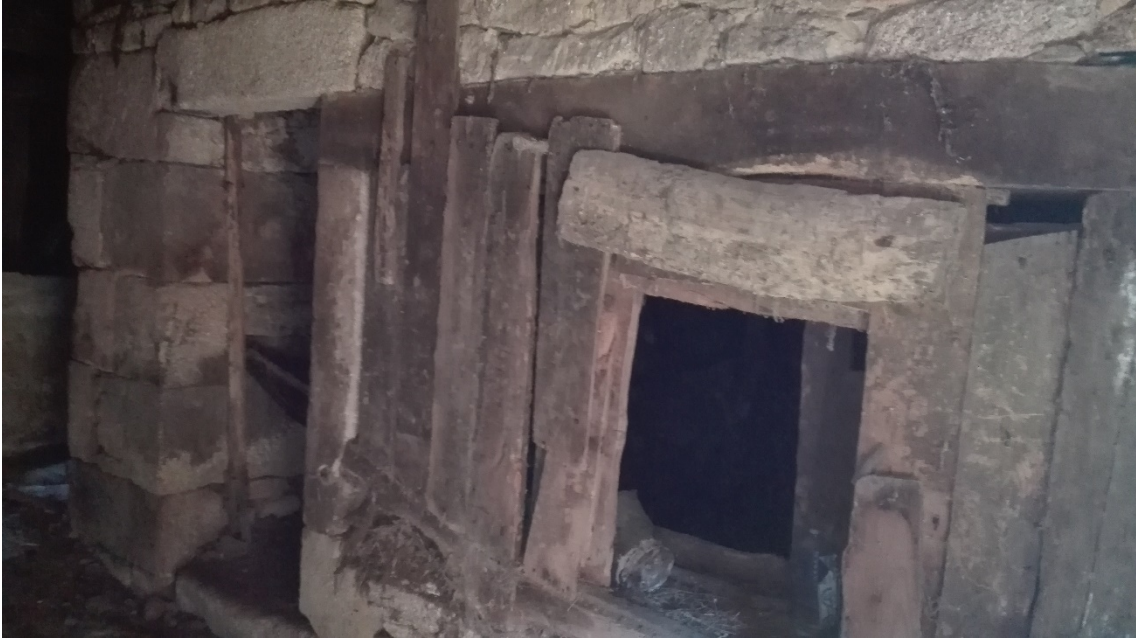
ILUSTRACIÓN 10. INTERIOR VIVIENDA B.
