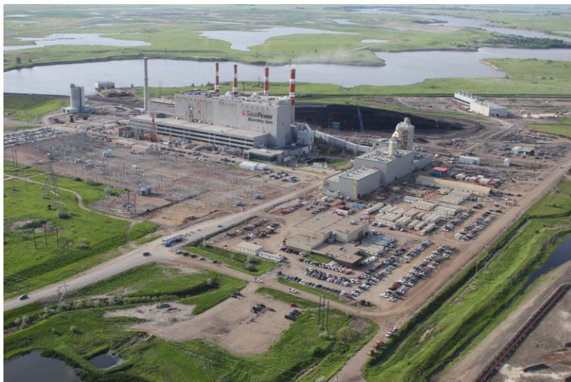
Imagen 2.2. Boundary Dam, Canadá, central térmica que desarrolla CAC mediante absorción química con aminas. 11, 12
