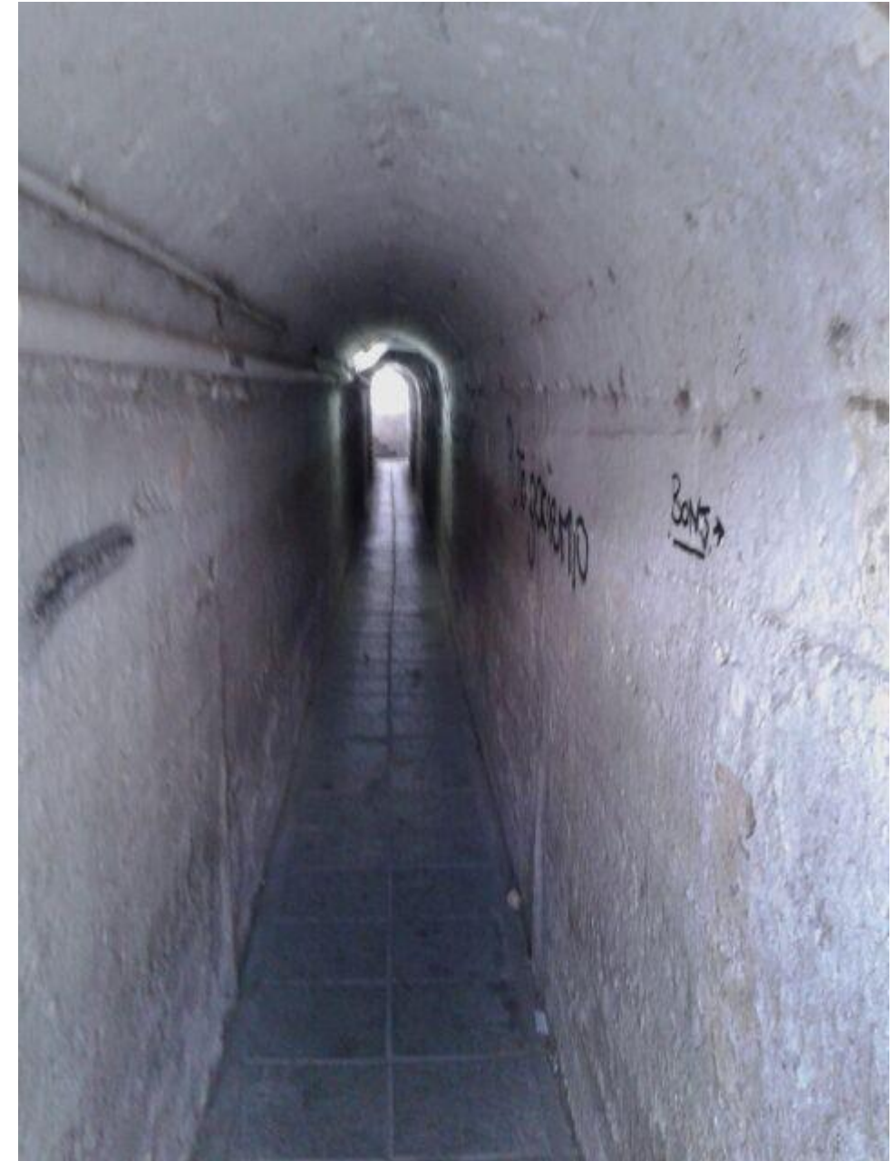
Interior del paso inferior actual
