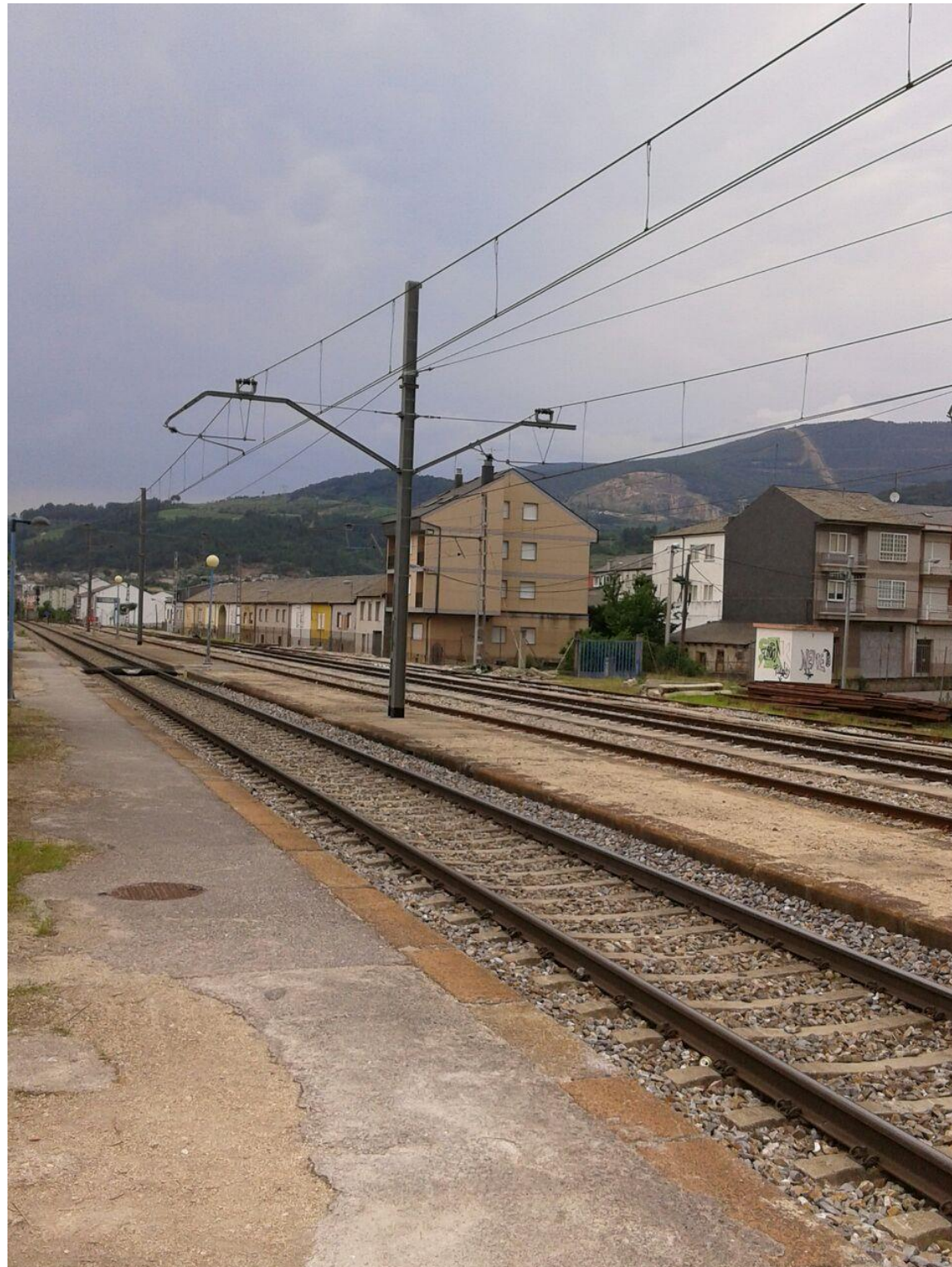
Imagen 8 – Ubicación futura del paso inferior, vista desde andén 1
