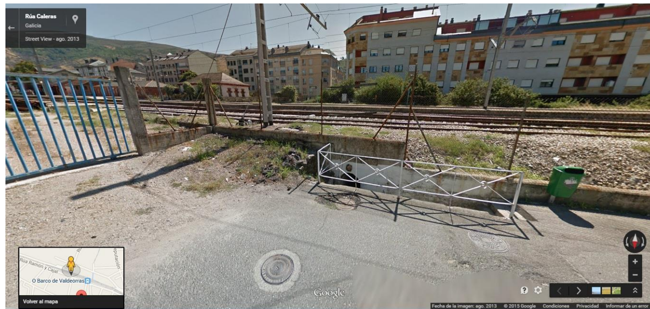
Imagen 1 – Acceso Norte del paso existente
