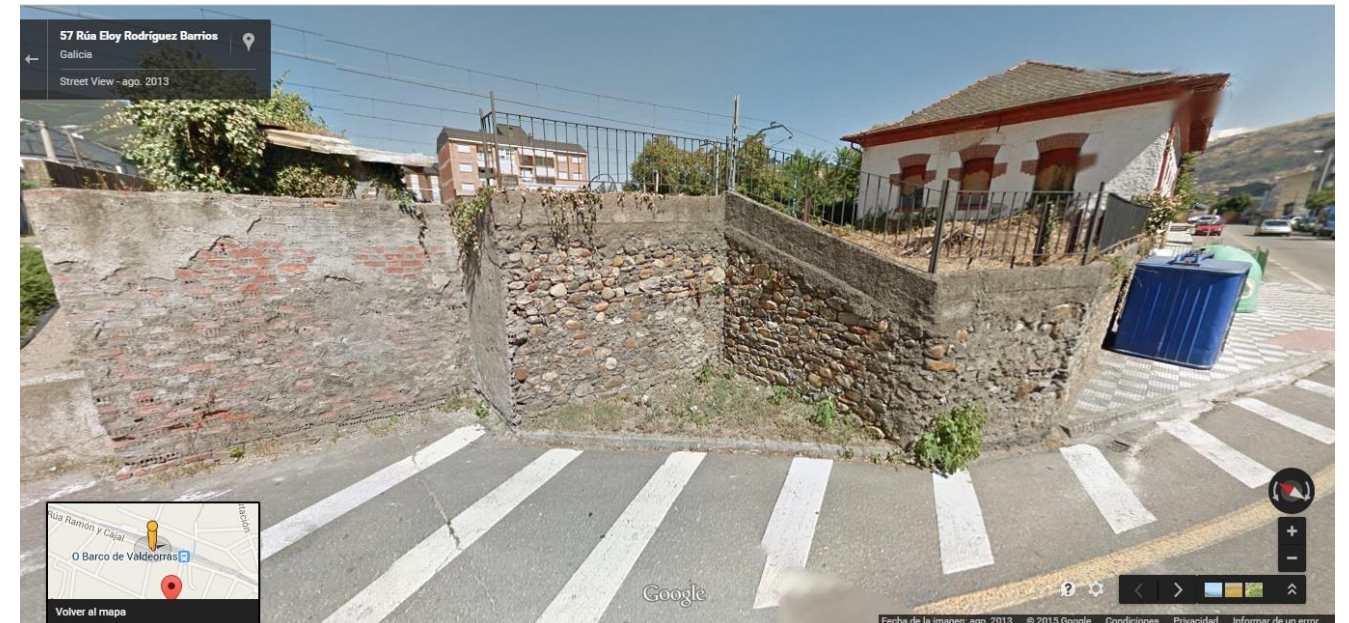
Imagen 5 – Acceso Sur del paso existente
