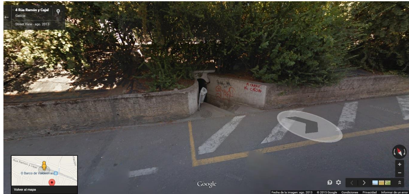
Imagen 3 – Acceso Sur del paso existente
