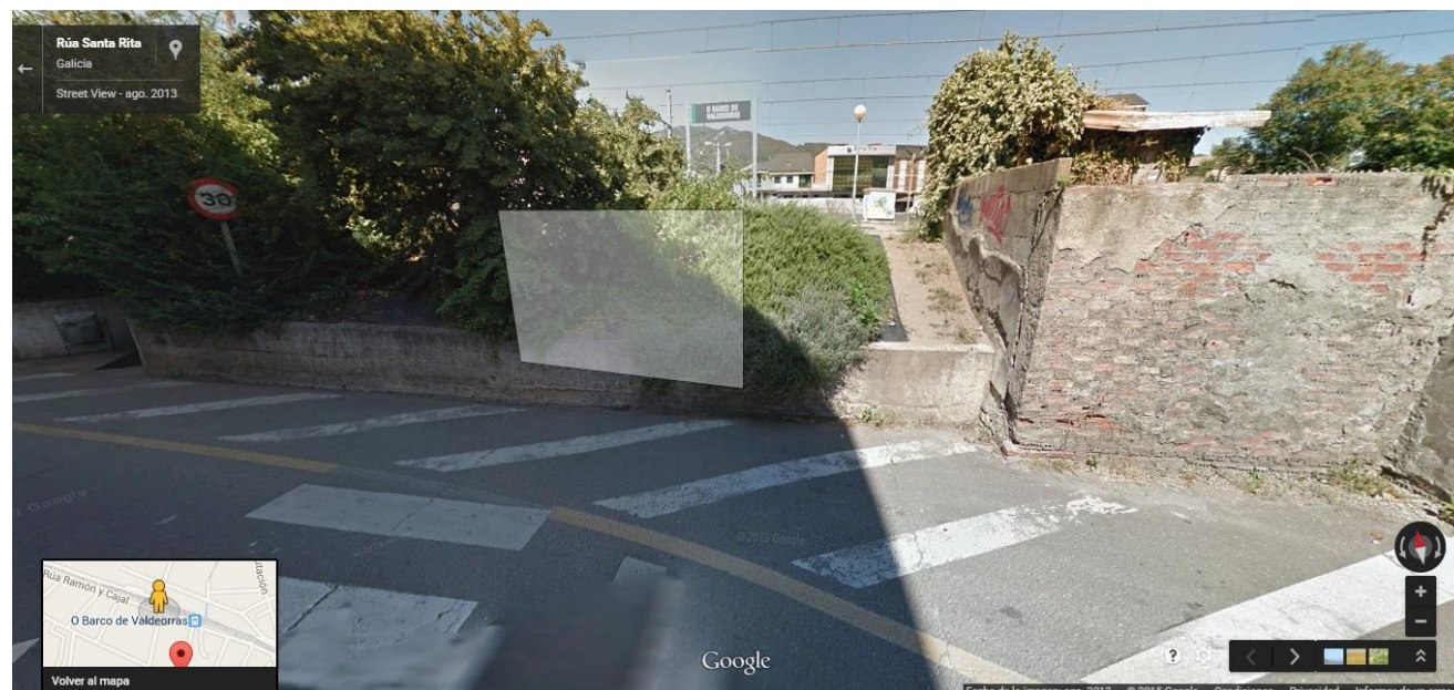
Imagen 4 – Acceso Sur del paso existente
