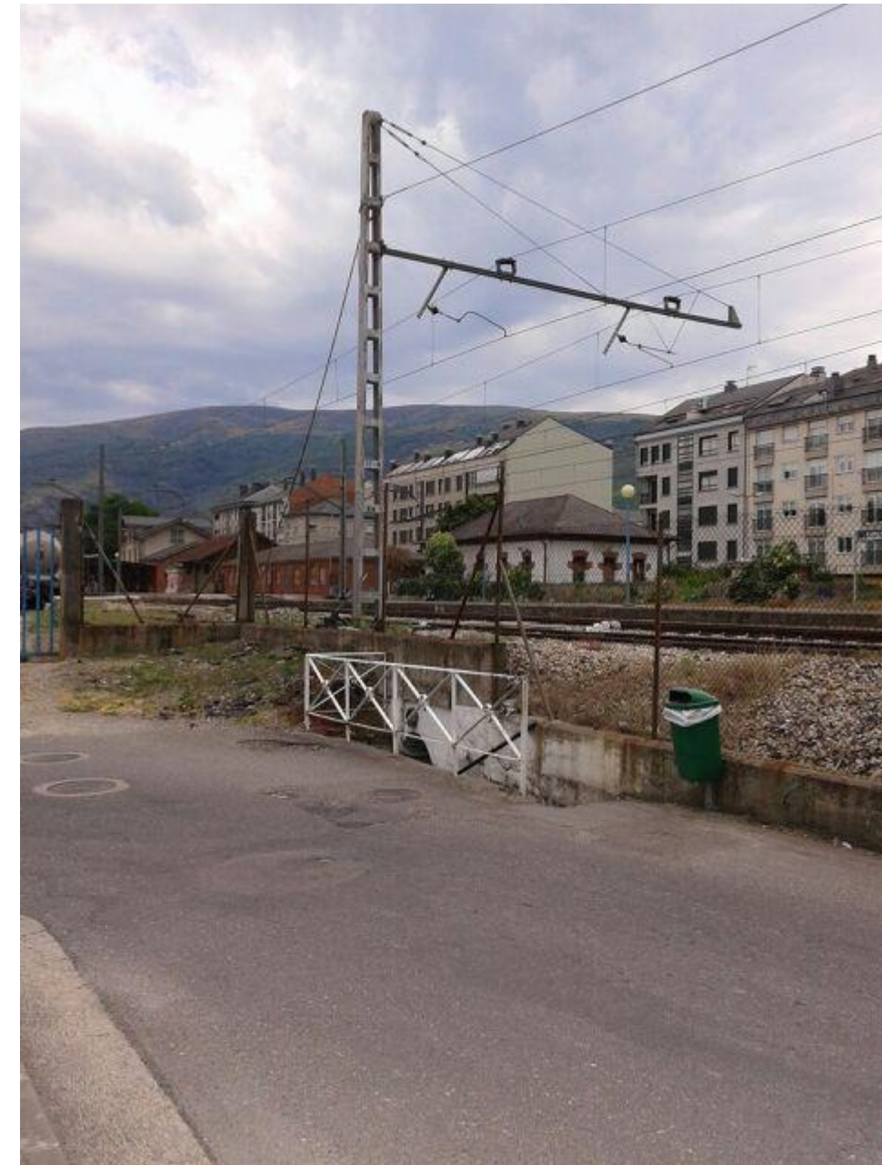
Imagen 2 – Acceso Norte del paso existente
