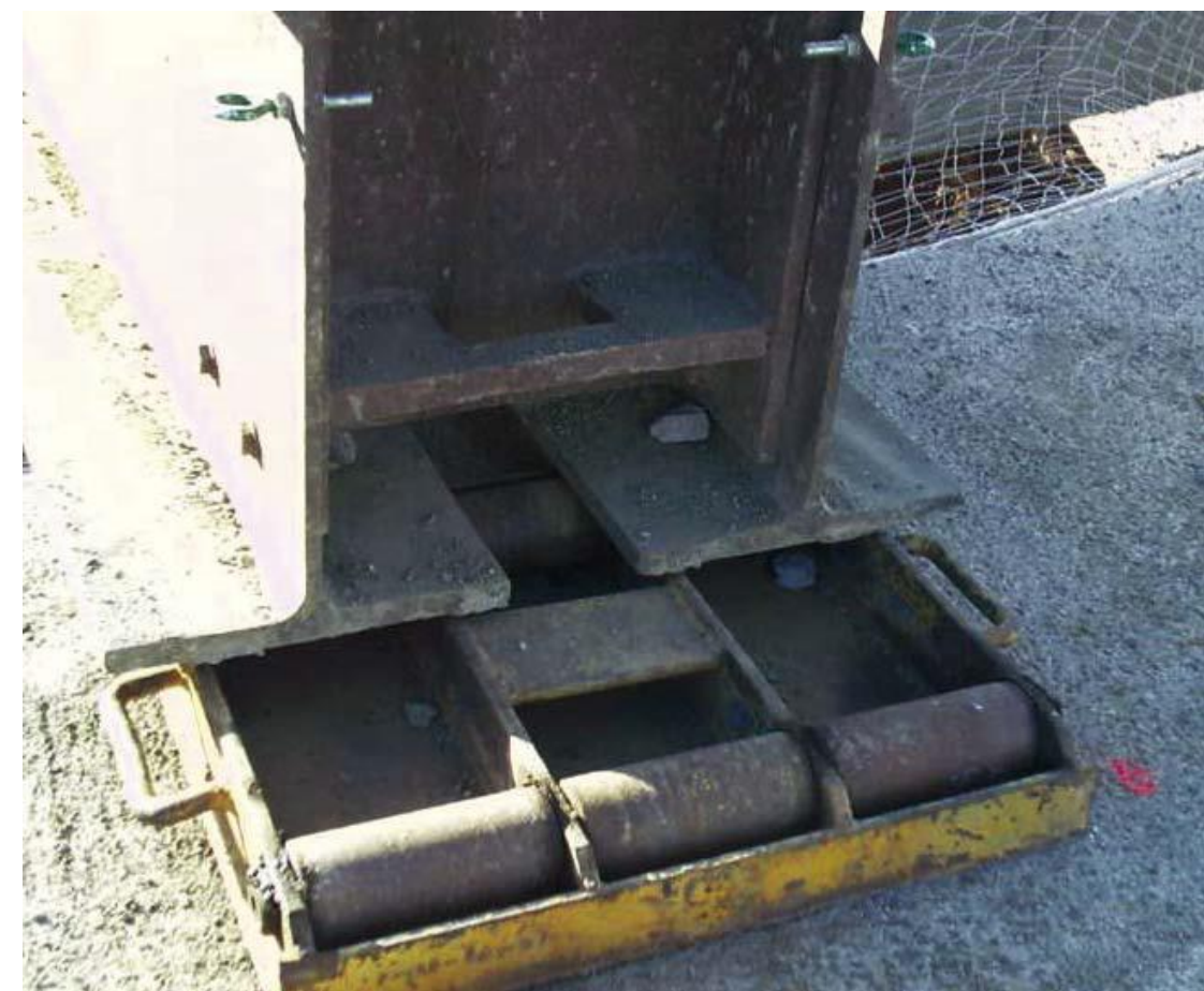
-Detalle de apoyo deslizante-
