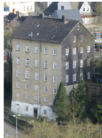
03.10. Vivienda colectiva en Weilburg, Alemania, 1828, https://bhutandiploma.wordpress.com/2011/04/26/earth-as-a-building-material/ , en mayo de 2016.
