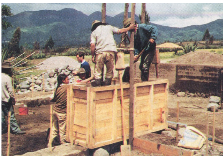
04.22. Relleno de una tongada de un muro de tapia, Bauluz del Río, G.& Bárcena Barrios, P. (1992). Bases para el diseño y construcción con tapia . Madrid: Centro de Publicaciones del Ministerio de Obras Públicas y Transportes.
