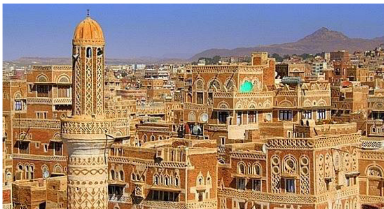
03.08. Edificios de adobe de la ciudad de Sanaa, http://schema-root.org/region/middle_east/yemen/municipalities/sana'a/ , en junio de 2016.
