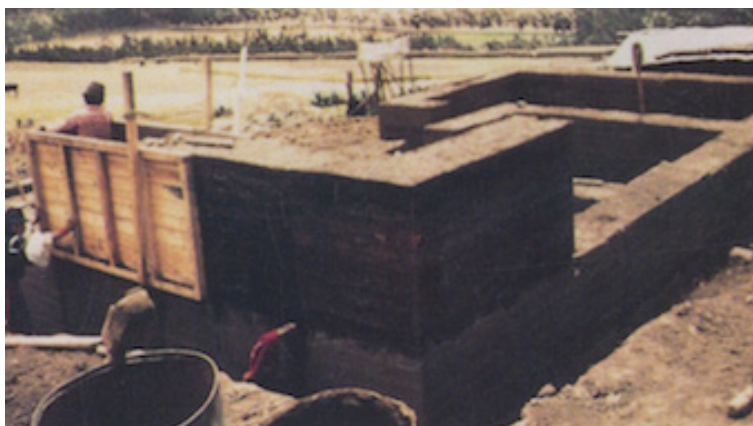
04.23. Comprobación de forma y estabilidad de los moldes, las hiladas se inician por las esquinas, Bauluz del Río, G. & Bárcena Barrios, P. (1992). Bases para el diseño y construcción con tapial . Madrid: Centro de Publicaciones del Ministerio de Obras Públicas y Transportes.
