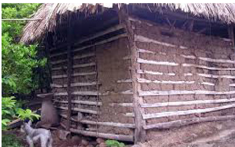
03.17. Construcción realizada con la técnica constructiva del bahareque, http://ibague-tolima.tripod.com/historialocal/pijaos01.html , en junio de 2016.
