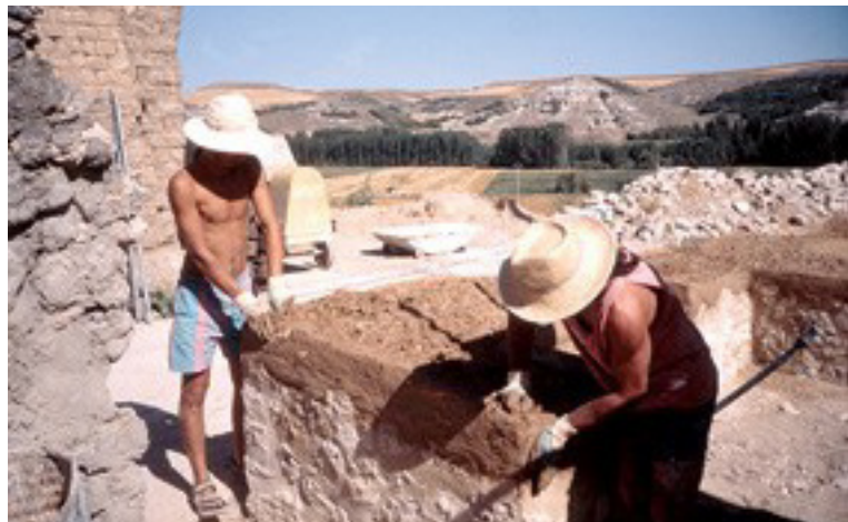
03.16. Trabajos manuales con cob, http://www.ecohabitar.org/wp-content/uploads/2013/02/mateu6.jpg .
