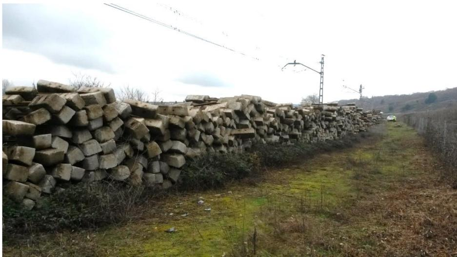
Figura 5.6. Fotografía de acopio de traviesas de hormigón
