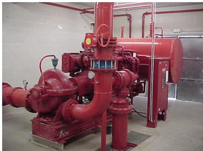
Equipo de Presión bajo normas americanas NFPA 20 y certificados
