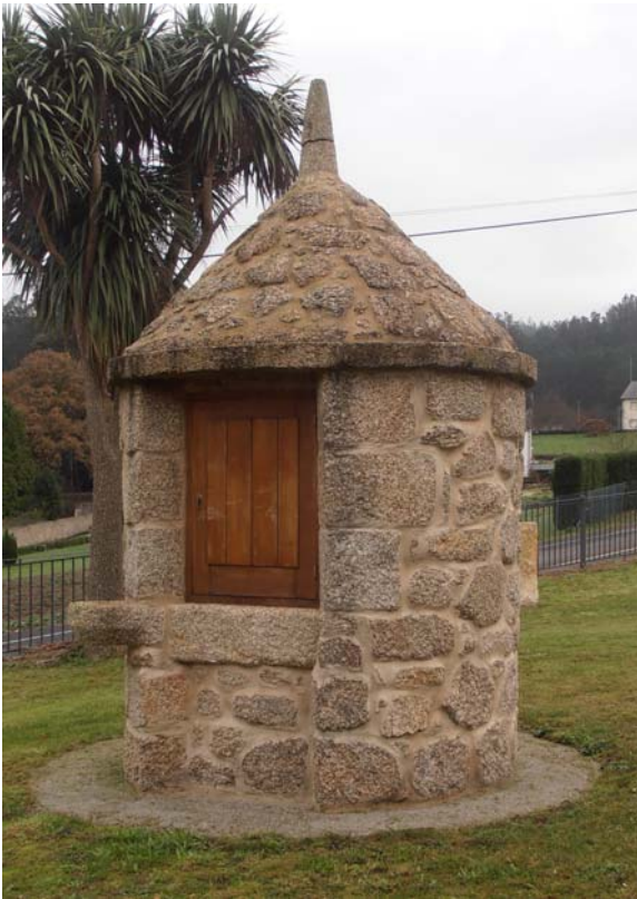
IMAXE 2.3.2.26.- Pozos. Depósitos de agua como decoración en espazos públicos.
