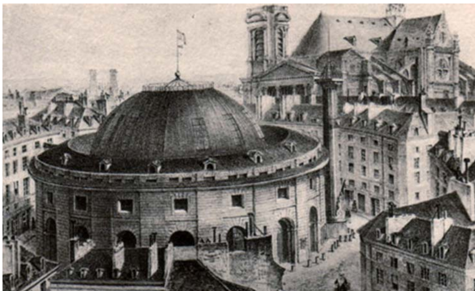
IMAXE 3.B.5.1.13.- Gravados con interior e exterior do Mercado, coa cúpula de estrutura de madeira e cristal, construída por Legrand et Molinos.
