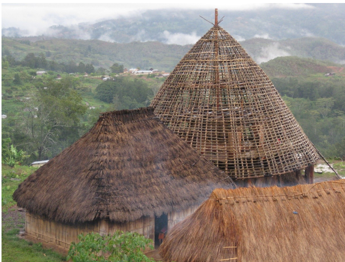
Fotografía 9. Uma-lulik en construcción.
