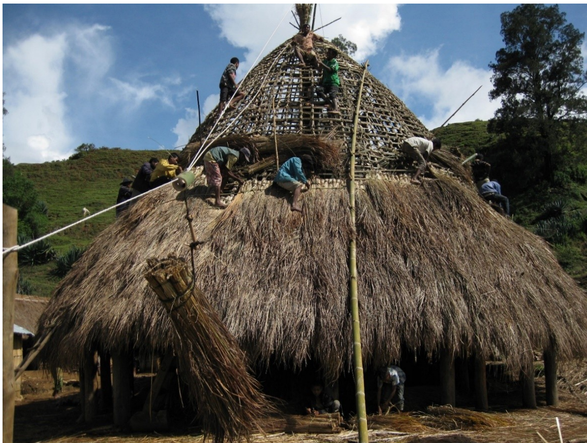
Fotografía 15. Colocación del techado ( suku uma ).
