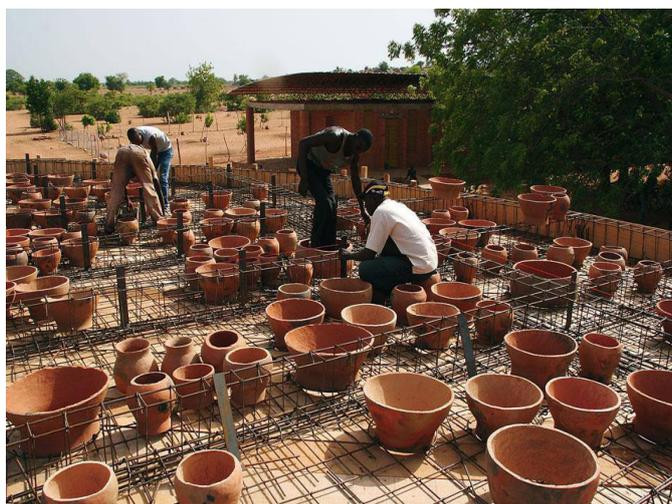
Fig. 3.1.03. Vasijas cerámicas a modo de encofrado.
