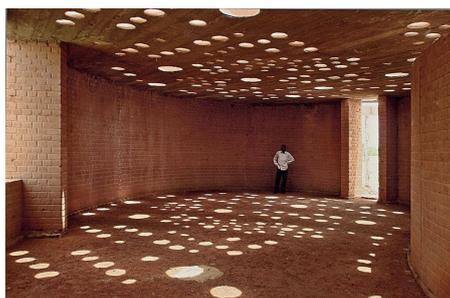
Fig. 3.1.04. Forjados aligerados de hormigón con vasijas cerámicas a modo de encofrado perdido.
