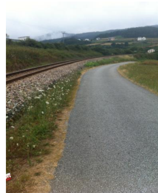
Foto 17: Vía del tren pegada a la carretera que comunica ambas playas, sin ningún tipo de sistema protector.
