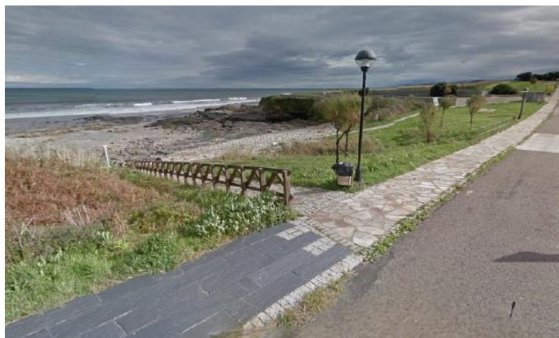
Ruptura de la continuidad en el paseo actual.
