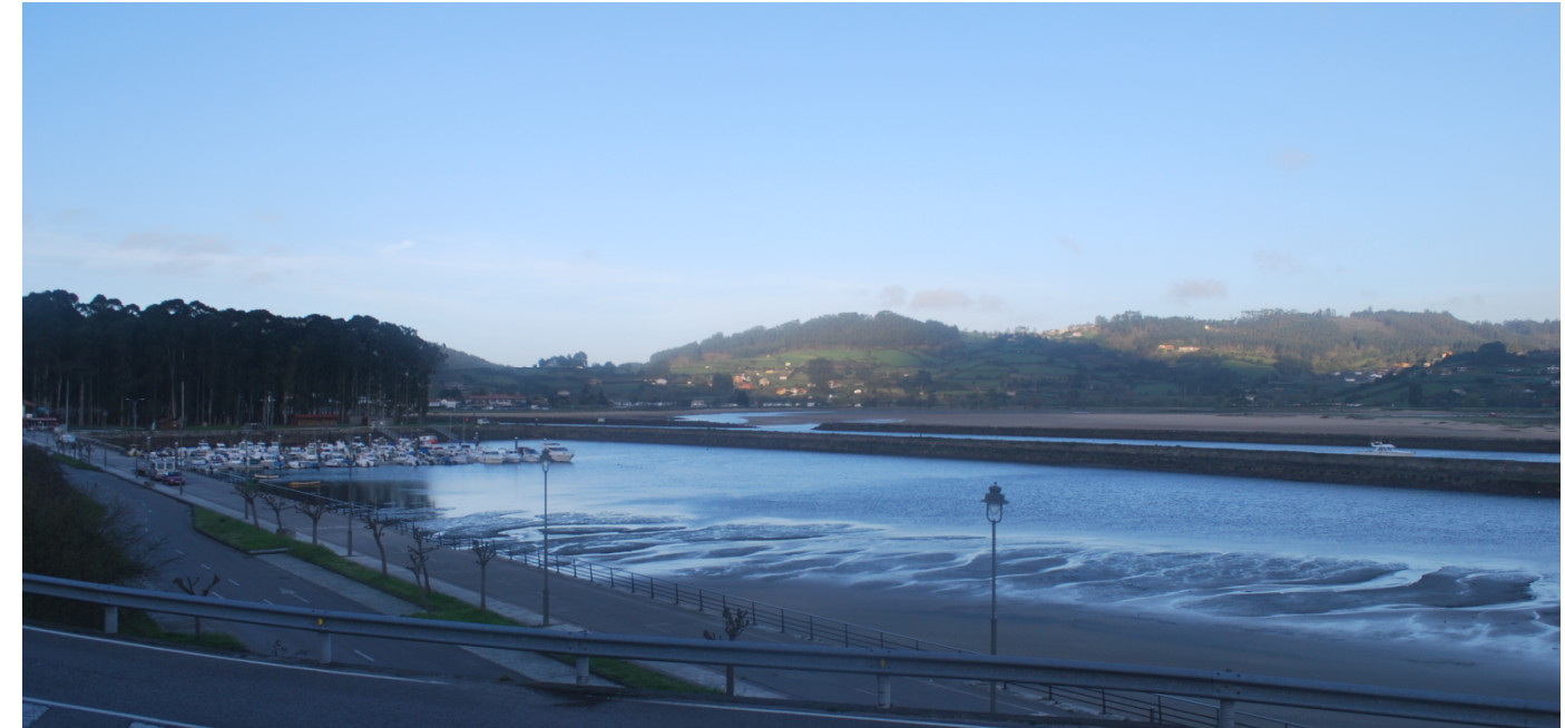
Vista general del puerto y dique D.
