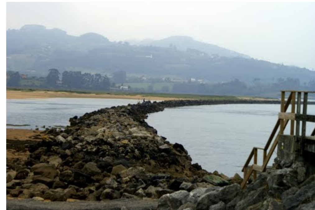
Aspecto del dique A. A la derecha, final del paseo actual.
