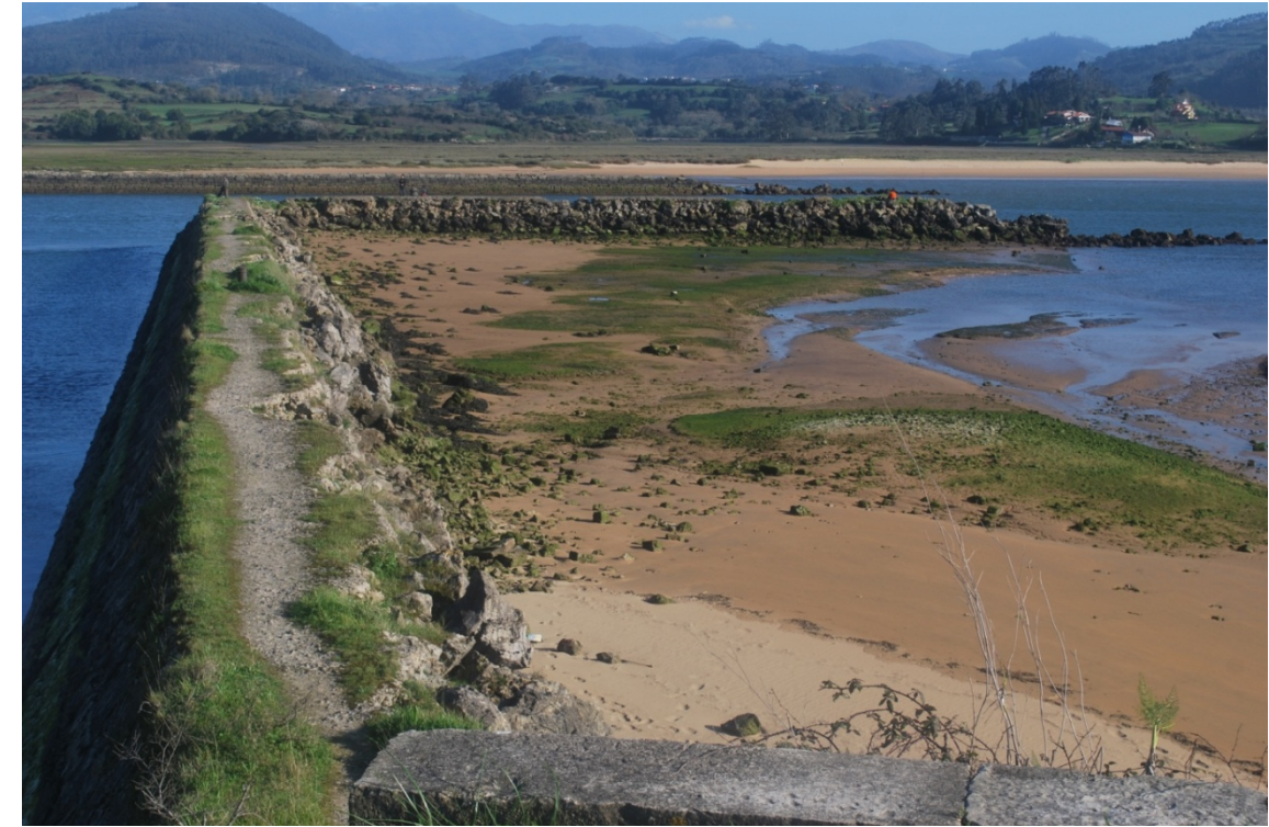
Aspecto dique C.
