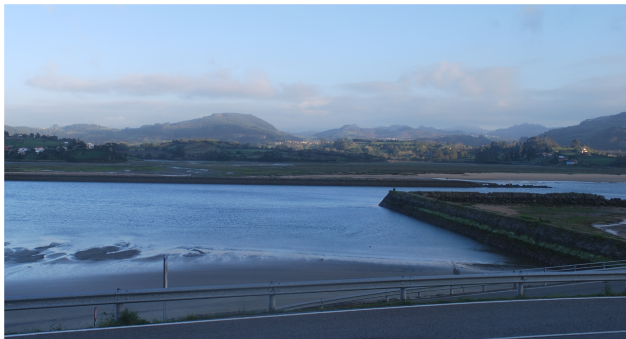
Vista general dique C. Al fondo, final del dique B.
