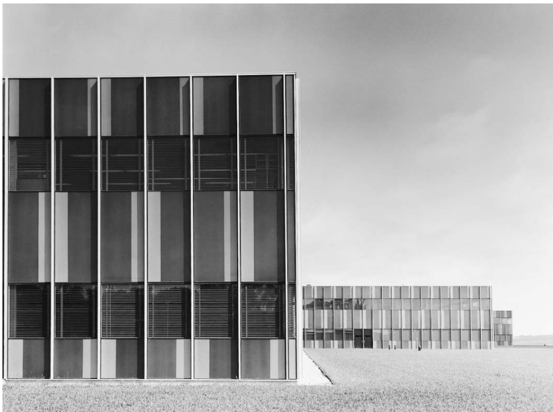
Ilustración 40. Eero SAARINEN, IBM Manufacturing and Training Facility , Rochester, Minnesota, 1958. Fotografía: Balthazar Korab.
