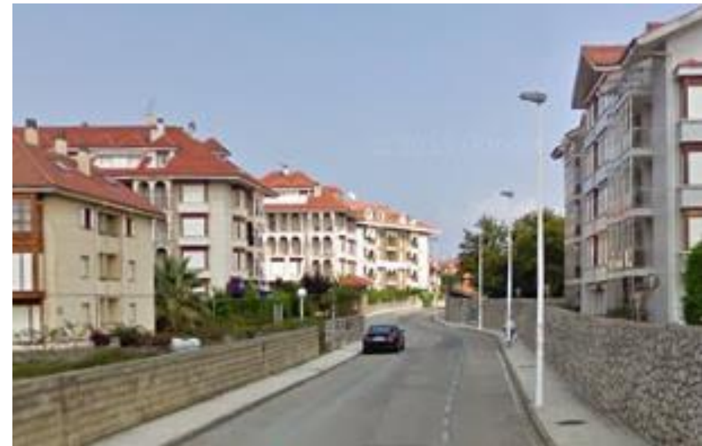
Noja. C/ El Casar (segundo tramo)
