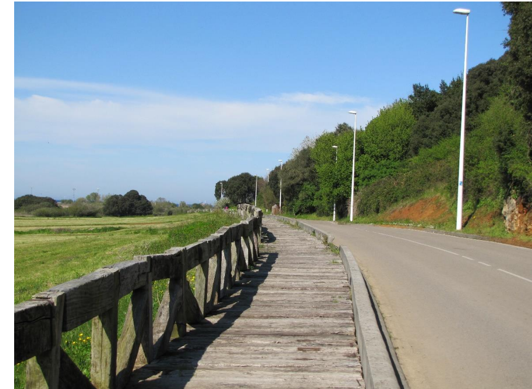
Carretera de Helgueras. Pasarela existente.
