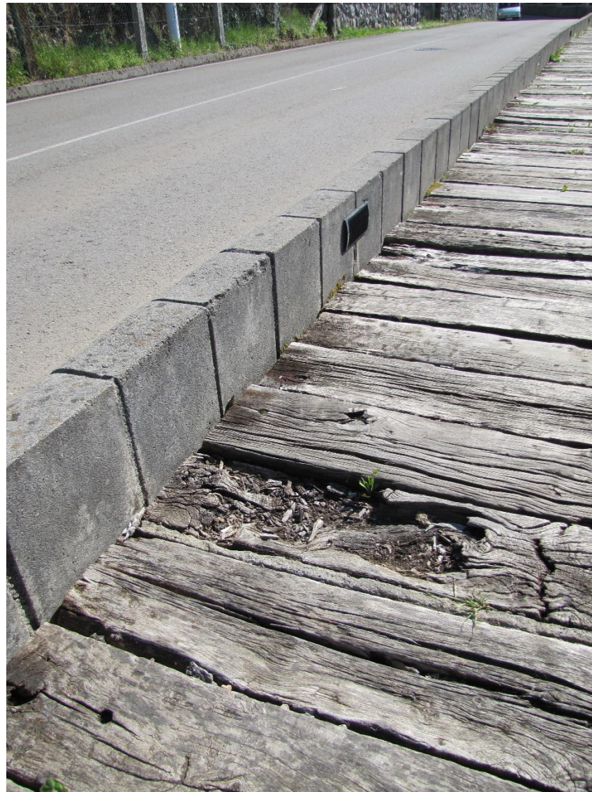
Estado actual de la pasarela existente
