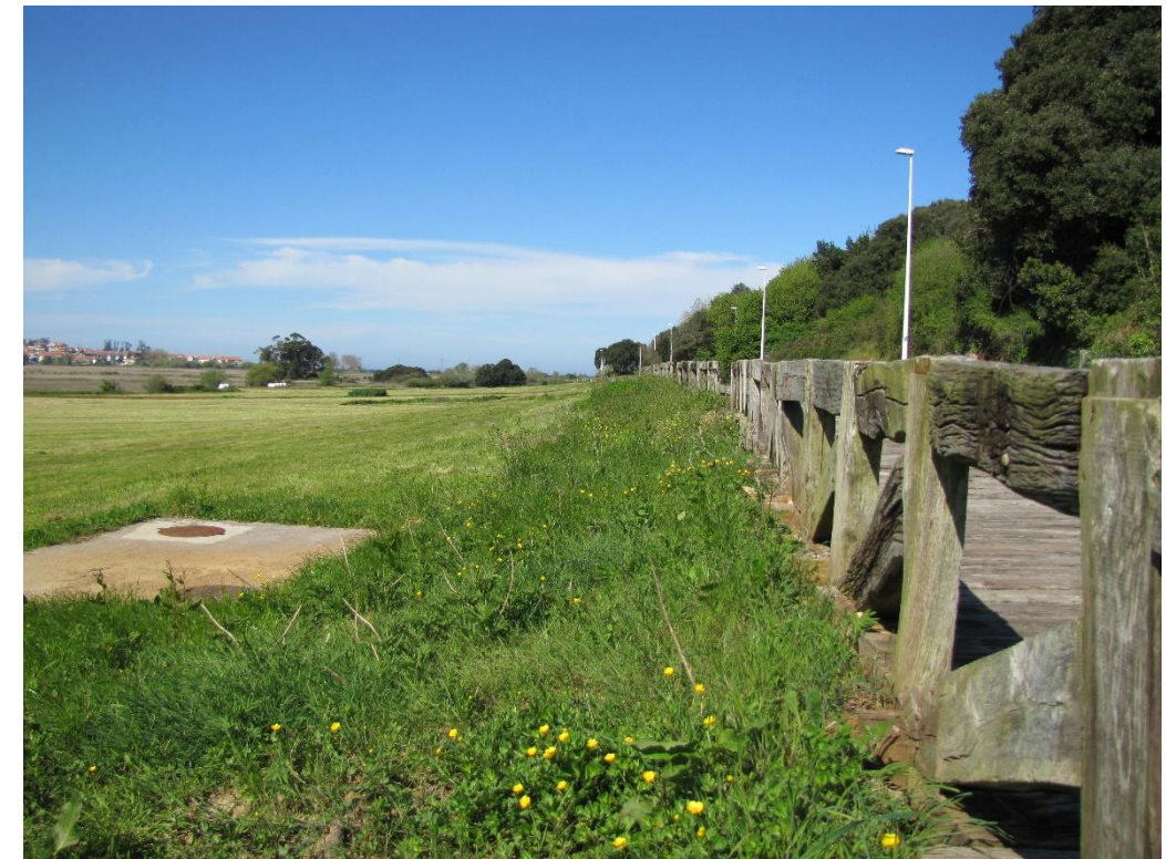
Helgueras. Pasarela existente
