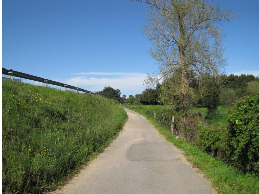
Castillo. Barrio Abajas (carretera ensanchada)
