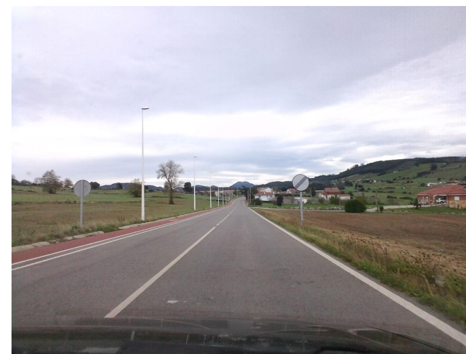
Meruelo. Carretera S-410
