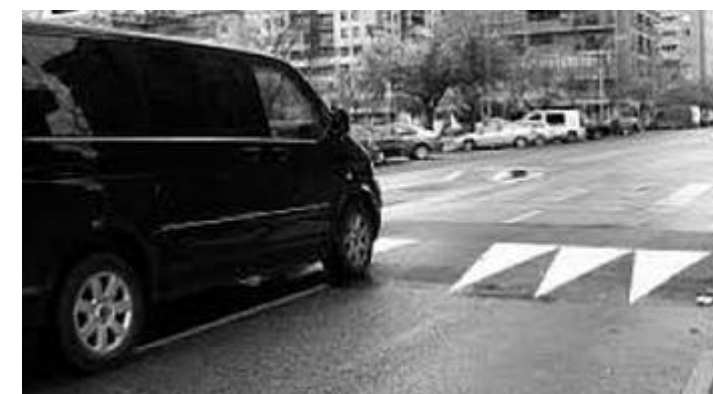
Figura 9. Fotografía Reductor de Velocidad tipo lomo de asno.
