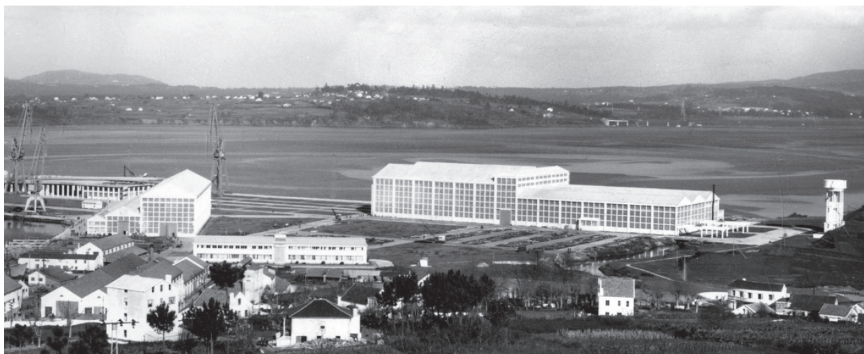
12 Vista general de los astilleros en 1965.
