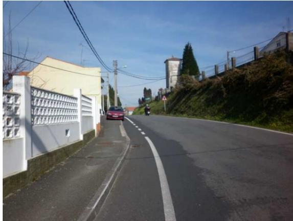
**FOTO 26:** Cambio de pavimento de la acera, ampliación de 1 m. el ancho de calzada hacia la izquierda y gran desmonte de talud.
