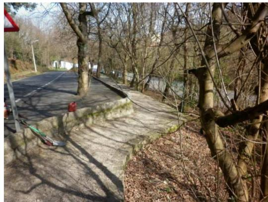
**FOTO 15:** Sendero existente en margen izquierda en sentido de avance necesario reforzar debido a desprendimientos del talud.
