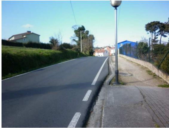
**FOTO 7:** Acera sin pavimentar, sin arcén a ambos lados e importante talud a desmontar para la realización de un aparcamiento y la senda peatonal.
