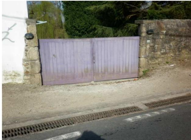
**FOTO 13:** Entrada pronunciada al Pazo de Lóngora que se solucionará rellenando el desnivel y levantado el portón a la cota de la acera.
