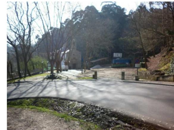
**FOTO 16:** Curva de radio reducido y de baja visibilidad junto a la Iglesia de Liáns. Bordes de calzada muy deteriorados.
