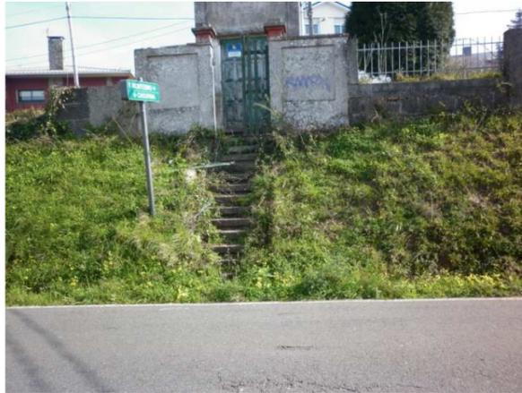
**FOTO 25:** Modificación de las escaleras que suben al transformador debido a la interrupción por la senda peatonal.
