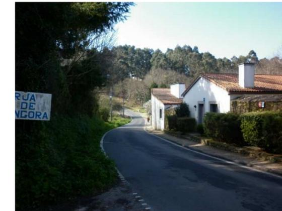
**FOTO 11:** Tramo con acera en mal estado y con ancho escaso de 1 m.
