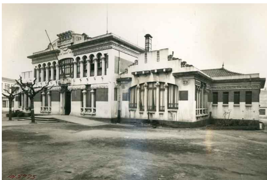
Imagen 2. Edificio de las escuelas totalmente finalizado (Archivo de la empresa)
