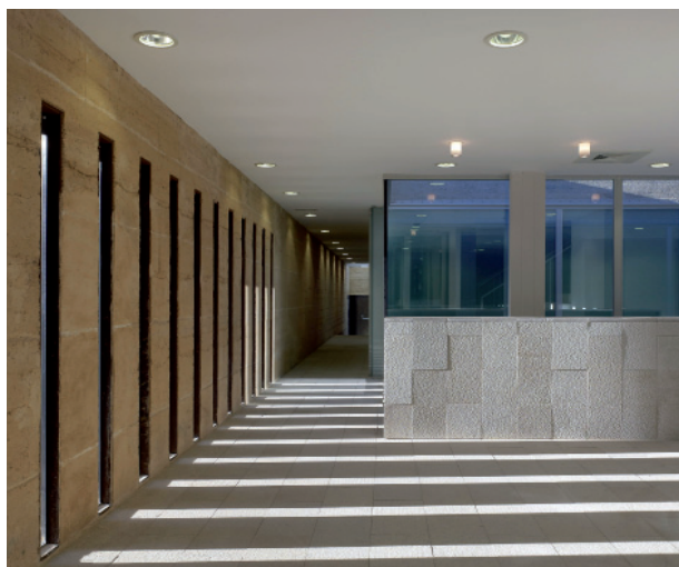
3 Aspecto interior del espacio de acceso, con la luz entrando a través de los huecos del tapial construidos con amazón metálico.
