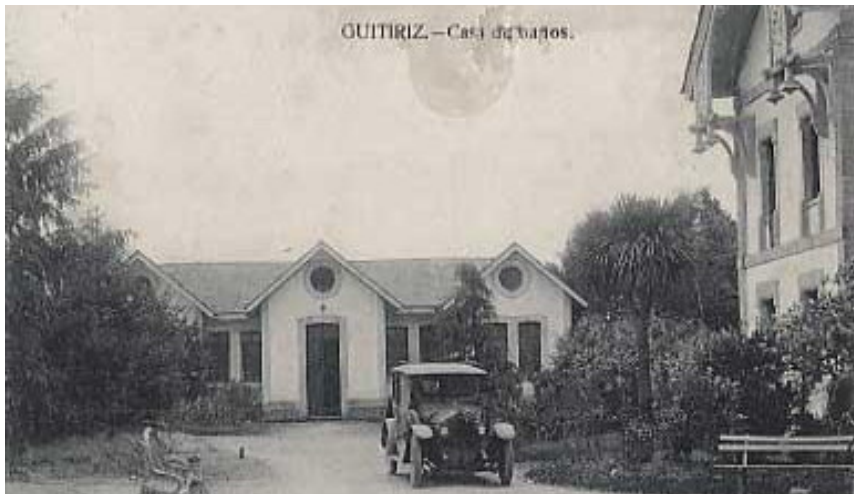
Vista del edificio de los baños, alrededor de 1910. Archivo particular de Urbano Barrio
