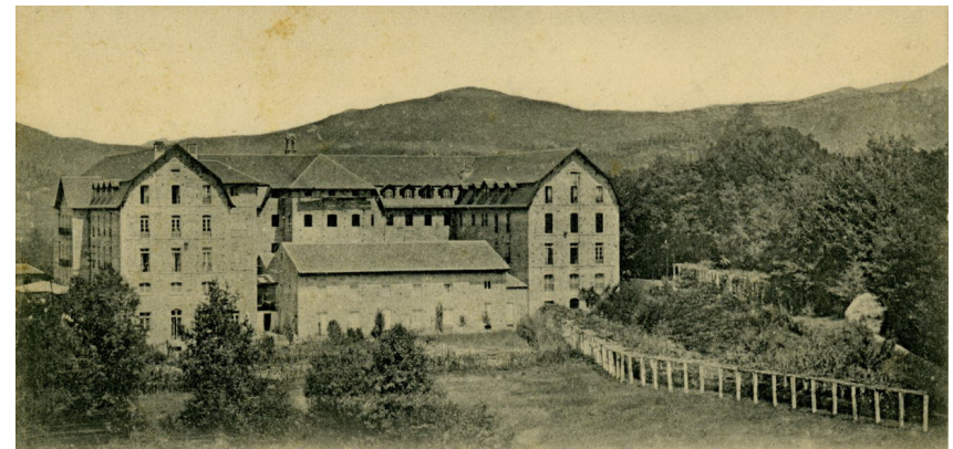
Vista de la fachada posterior, en la que pueden apreciarse el volumen del teatro ocupando el espacio central, también la caja de escaleras adosada al ala oeste y las pequeñas ventanas de la entreplanta en esa ala. Fuente: Archivo del Reino de Galicia
