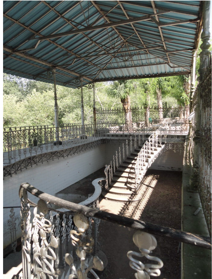
Vista actual del interior del pabellón de la fuente del Troncoso. ML
