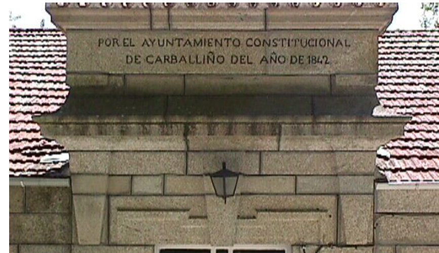
Detalle de remate de la entrada en donde consta el año de su construcción. ML
