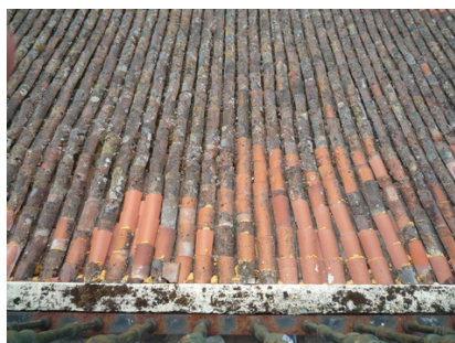
Vista de la cubierta de la zona de baños con teja curva y de la zona de descanso, al fondo, con teja plana. ML
