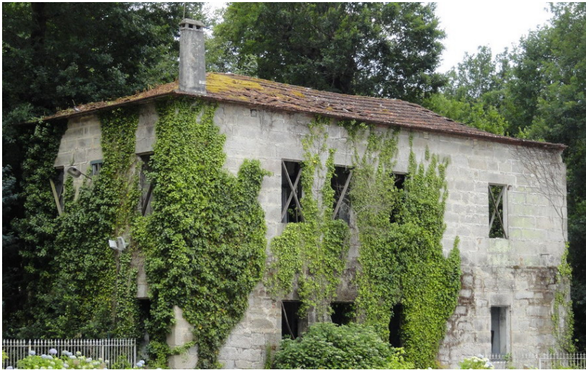
Vista actual del denominado edificio nº 4 fachadas este y norte. ML
