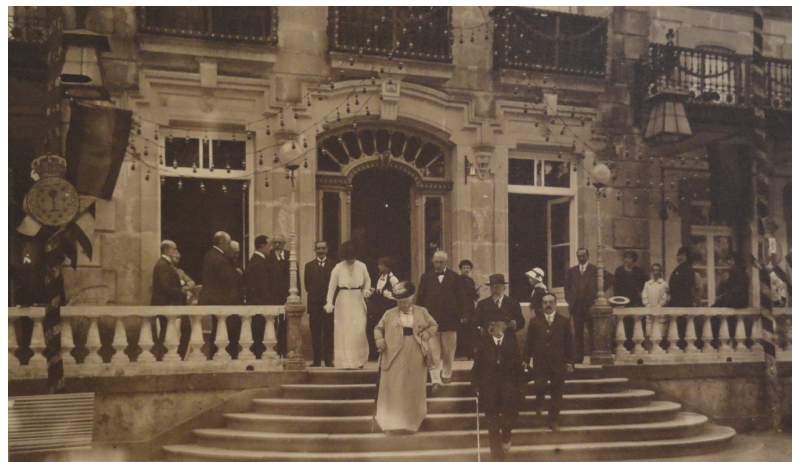
Detalle del acceso en el que puede apreciarse la ligereza constructiva de los porches laterales. Visita de la infanta doña María Isabel, julio de 1914
