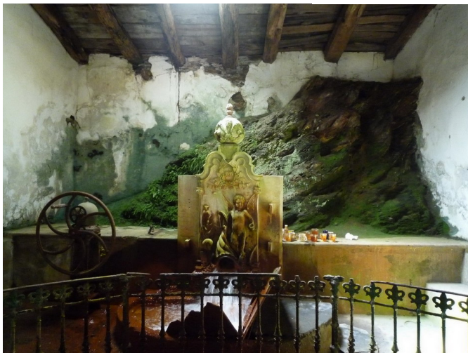
Vista actual de la misma fuente y detalle del tragaluz de una de las salas laterales. ML
