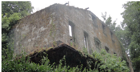
Vista actual del edificio nº 3 fachada principal y lateral de la que arrancaba la escalera exterior. ML
