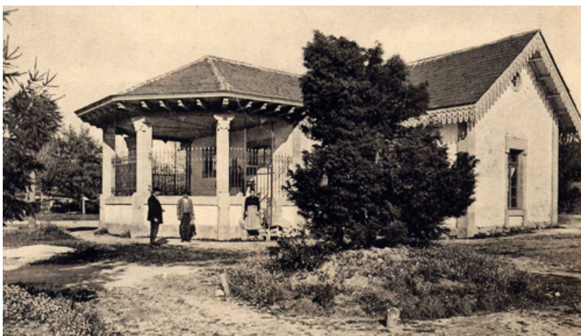
Vista del edificio de la fuente y capilla, alrededor de 1920. Archivo particular de Urbano Barrio
