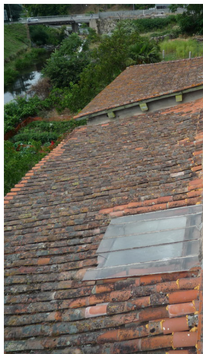
Vista de la cubierta de la zona de baños con teja curva y de la zona de descanso, al fondo, con teja plana. ML
