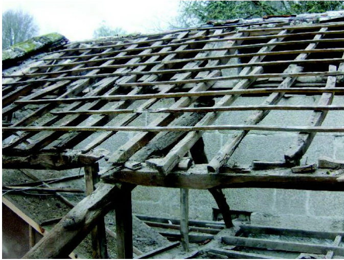
Vista del entramado de cubierta y la estructura del forjado a uno y otro lado del muro de carga intermedio, 2010.
