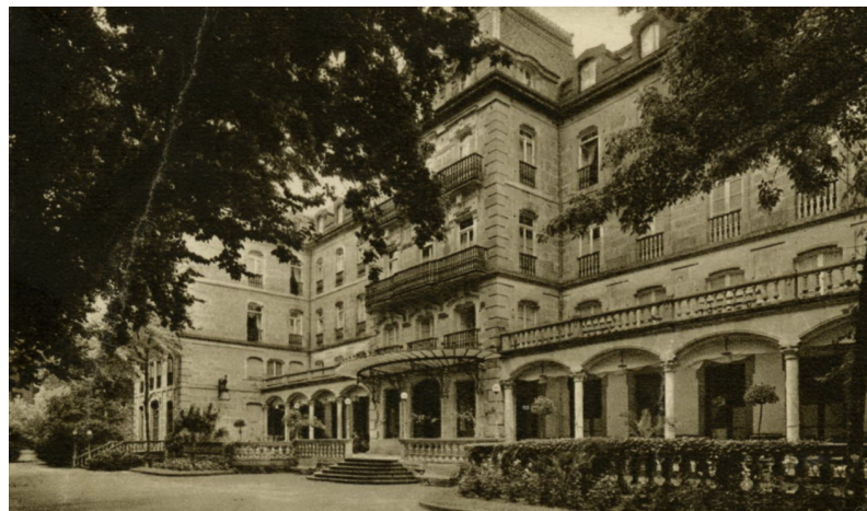
Vista de la fachada principal con el nuevo porche, la marquesina de la entrada y la ampliación de las terrazas inferiores. Archivo del Reino de Galicia
