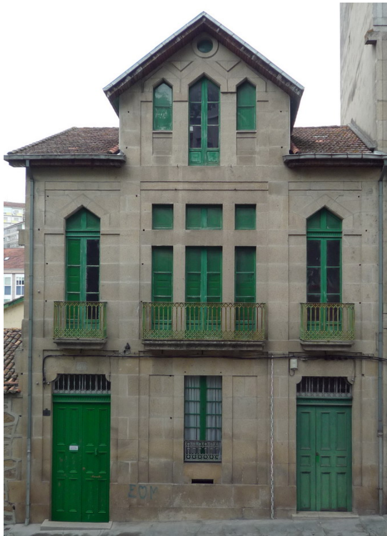
Vista de la fachada principal en la actualidad. La puerta derecha da acceso a la vivienda principal y la izquierda al resto de viviendas y los baños. ML
