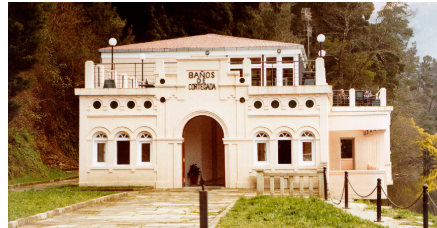
Fachada norte del balneario por la que se realiza el acceso. Se le ha añadido un cuerpo en su parte superior, sobre la cubierta plana. ML
