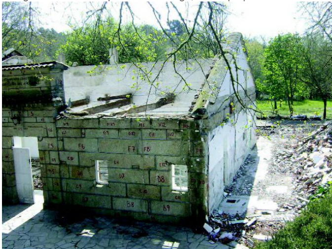
Vista del entramado de cubierta y la estructura del forjado a uno y otro lado del muro de carga intermedio, 2010.
