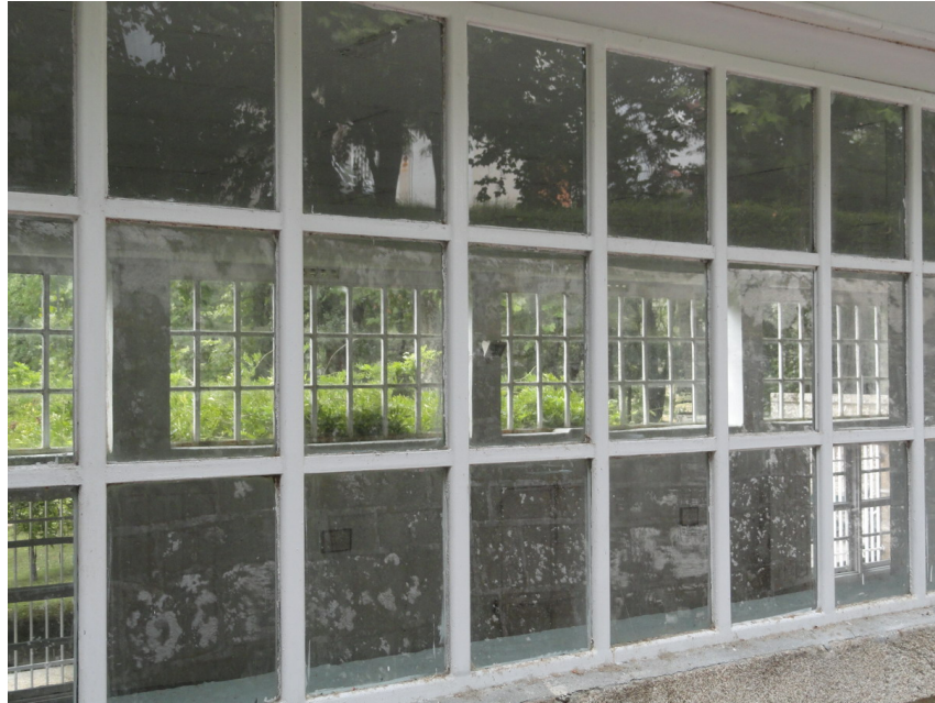
Vista en la que se puede apreciar la transparencia a través del pabellón de la fuente. ML
