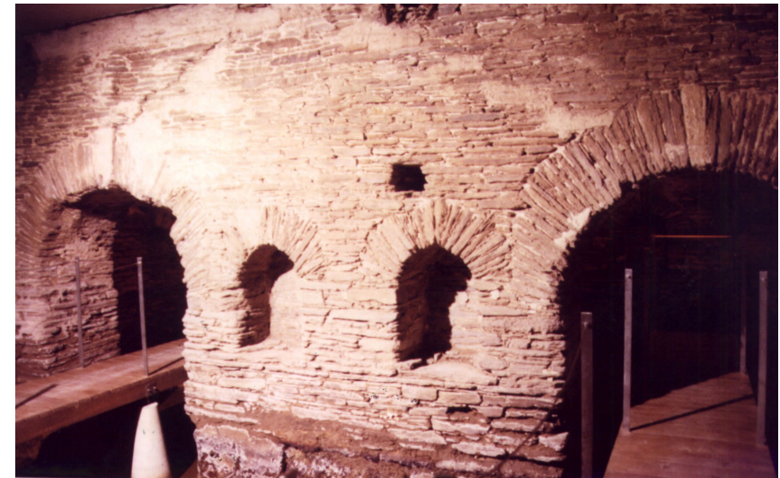
Vista de los restos romanos desde el vestíbulo previo con las entradas a las dos salas. ML
