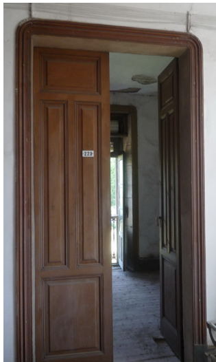
Detalle de divisiones en el bajo-cubierta y puerta en plantas de dormitorios que todavía se conservan
