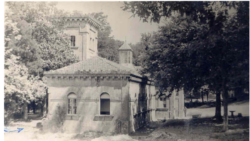
Vista del edificio que alberga los baños, fachada sur, al fondo hacia la derecha la "Reino de Galicia
