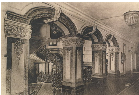
Detalle del acceso a la escalera desde el pasillo de la planta principal, alrededor de 1930. Álbum del Balneario de Mondariz
