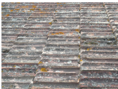
Los dos distintos tipos de teja que se encuentran en la actualidad. ML
