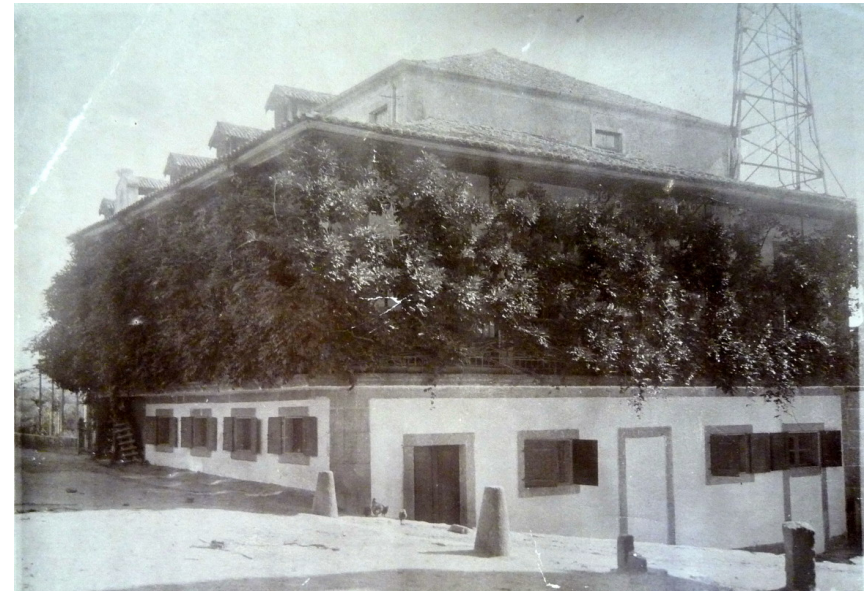
El edificio del balneario en planta baja, con la vivienda de la propiedad oculta por la enredadera. Puede verse sobresaliendo las buhardillas del hotel. Alrededor de 1930
