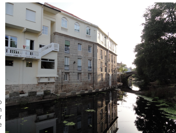
Vista actual del balneario ubicado al borde del río en el que se puede apreciar el edificio original, de sillería. ML
