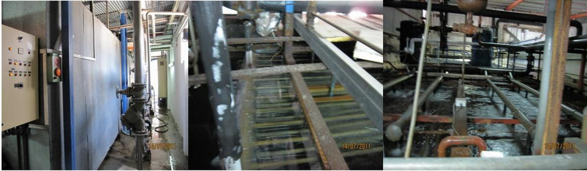
Foto 8.23. Vista de la balsa Fotos 8.24 y 8.25. Serpentines de amoníaco y tuberías de retorno
