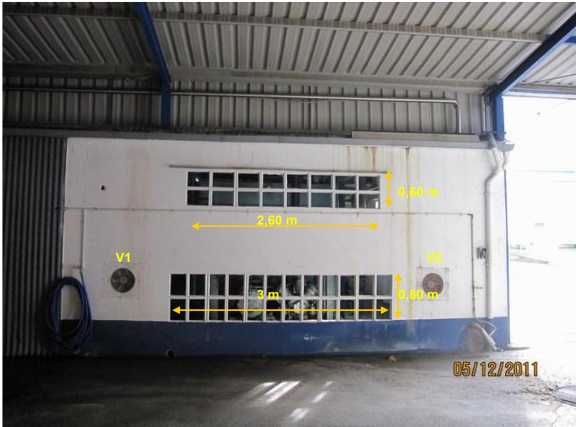
Foto 8.28. Ventilación natural de la sala de frío 3
