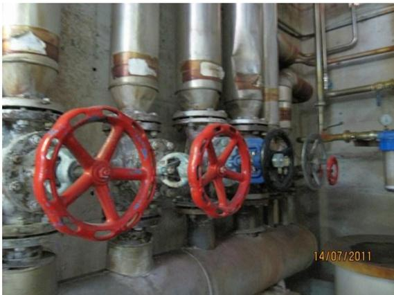
**Foto 4.31.** Colector de vapor de salida
