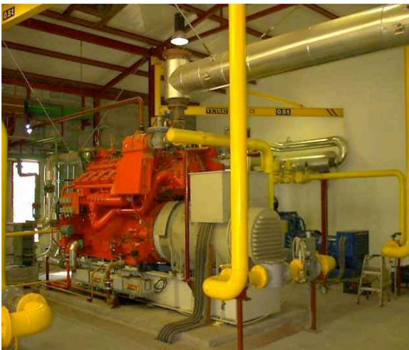
**Foto 9.8.** Motor de generación de energía eléctrica
