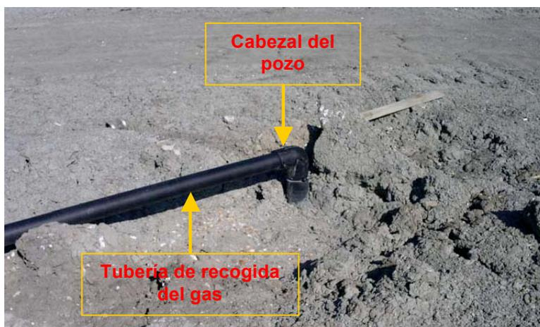
Foto 9.1. Pozo de captación y tubería de recogida de gas
