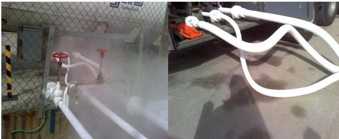
Fotos 8.1. y 8.2. Proceso de descarga de gas
