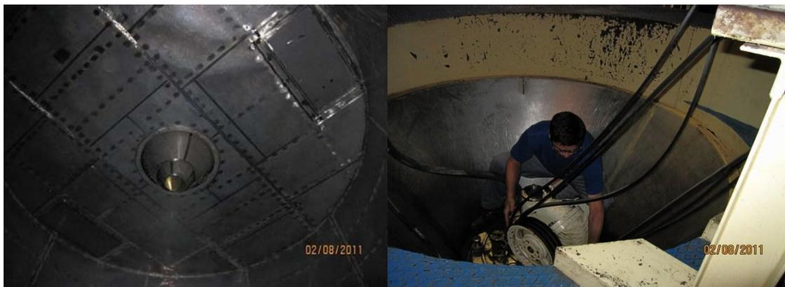
**Fotos 8.75 y 8.76.** Ubicación y colocación del atomizador en la cámara de secado
