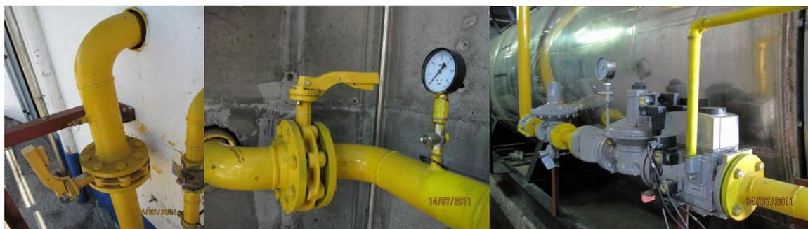
Foto 8.5. Tubería gas Foto 8.6. Válvula de corte manual Foto 8.7. Línea de los quemadores
