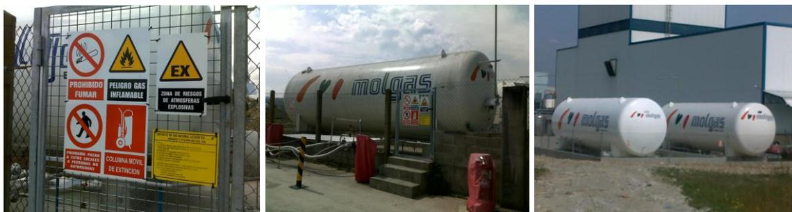
Fotos 4.24, 4.25 y 4.26 (izquierda derecha). Señalización ATEX, vista del primer depósito de GNL y vista de los dos depósitos de 60.000 litros cada uno en la parte posterior de la fábrica
