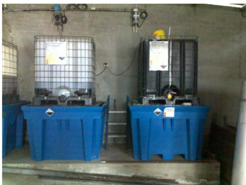
Foto 4.44. Depósitos cloruro férrico y ácido
