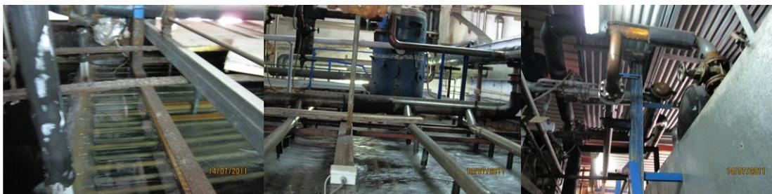
Fotos 4.36, 4.37 y 4.38 (izquierda-derecha). Conducciones de las balsas de agua helada
