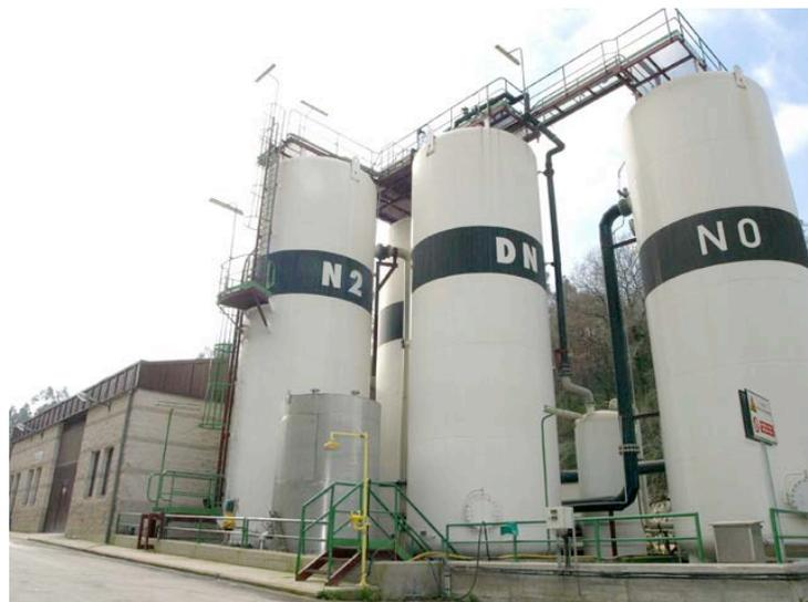
**Foto 9.10.** Tanques de almacenamiento de metanol
