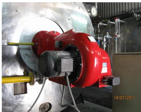
Foto 4.30. Quemador (entrada llama piloto y gas)
