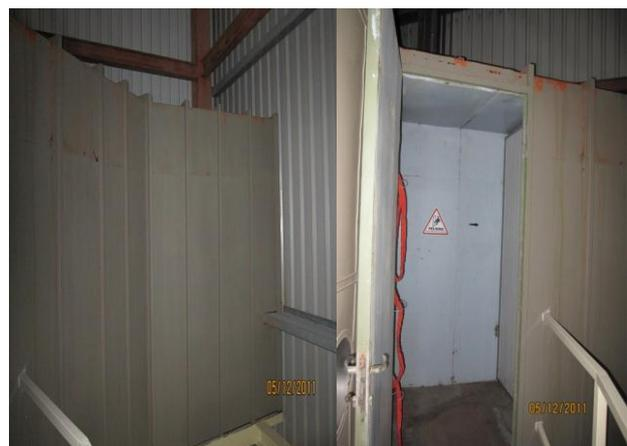
Fotos 4.53, 4.54 y 4.55. (izquierda-derecha). Dimensiones (ancho-alto) del pasillo de alivio de presión, vista del pasillo de alivio desde el interior de la torre y puerta de entrada al pasillo y a la puerta de sobrepresiones
