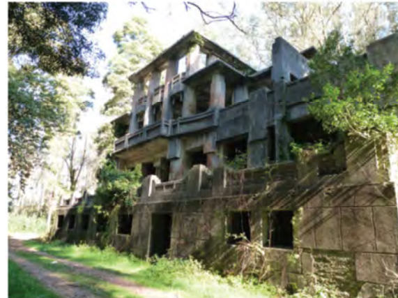
Sanatorio de Cesuras, aspecto actual.
