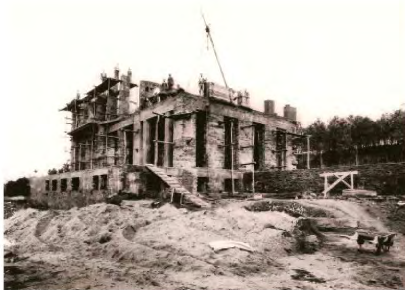
Sanatorio de Cesuras en construcción.
