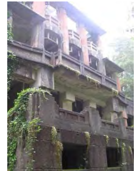
Sanatorio de Cesuras. Aspecto actual.2.
