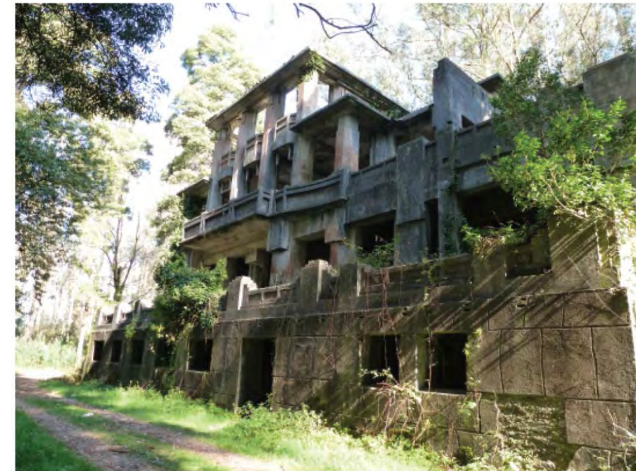
Sanatorio de Cesuras, aspecto actual.
