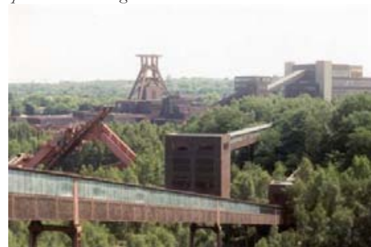
Figura 37 Zollverein, Edificacións industriais nas que sitúan equipamentos e todo iso enmarcado nunha importantísima rexeneración paisaxística ó longo de 11km.
