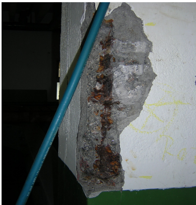
Figura 1.17 Corrosión en Oceanográfico de Vigo (E. Mosquera. 2006)
