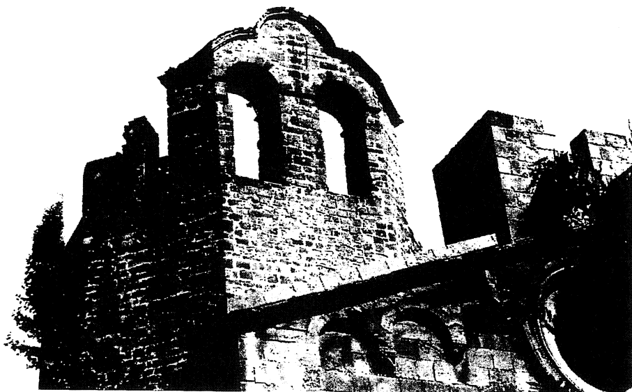
Fig. 1. Corrosión de monumentos
