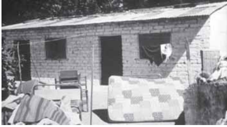
Fig. 2.- Vivienda no mejorada y tratada del Grupo III.
