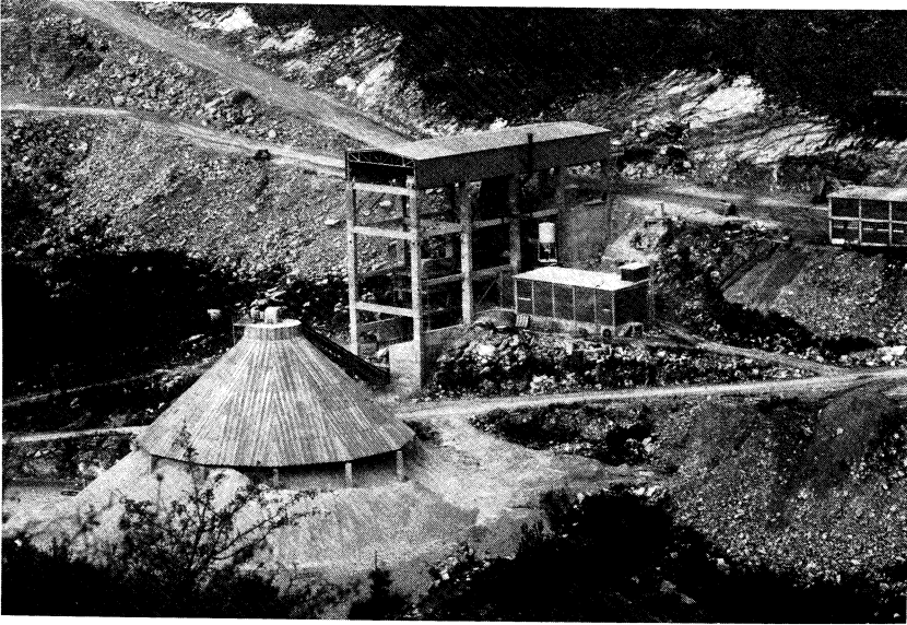
Fig. 18°.- Planta de trituración y almacenamiento
