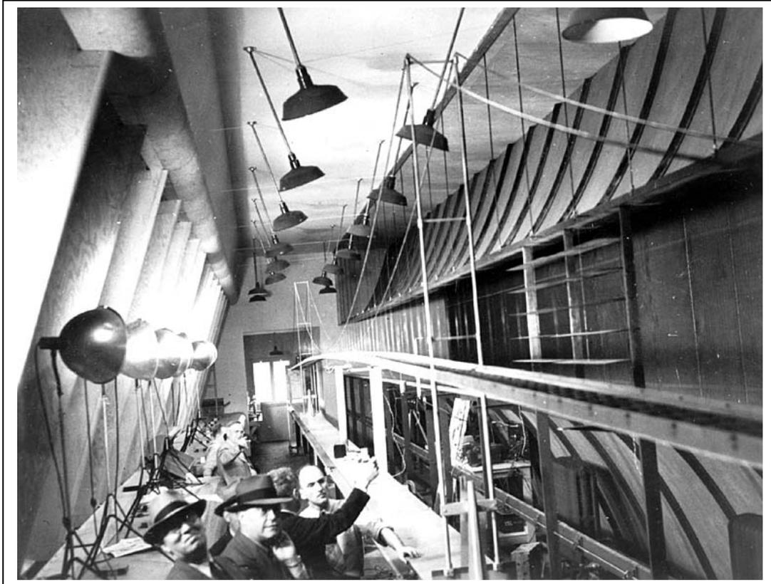
Figura 2.2.3. Modelo del puente sobre el estrecho de Tacoma en el túnel de viento de la Universidad de Washington.
