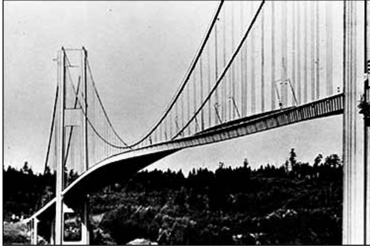
Figura 2.1.1. Movimientos de puente sobre el estrecho de Tacoma antes del colapso.
