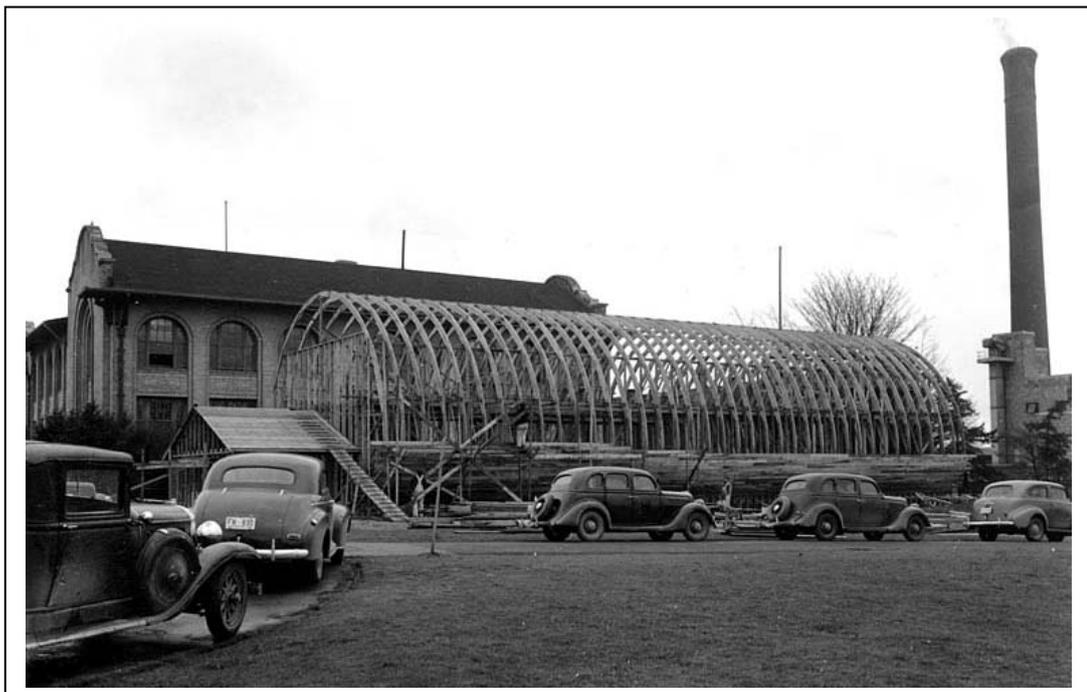
Figura 2.2.2. Túnel de viento construido en la Universidad de Washington en 1942.
