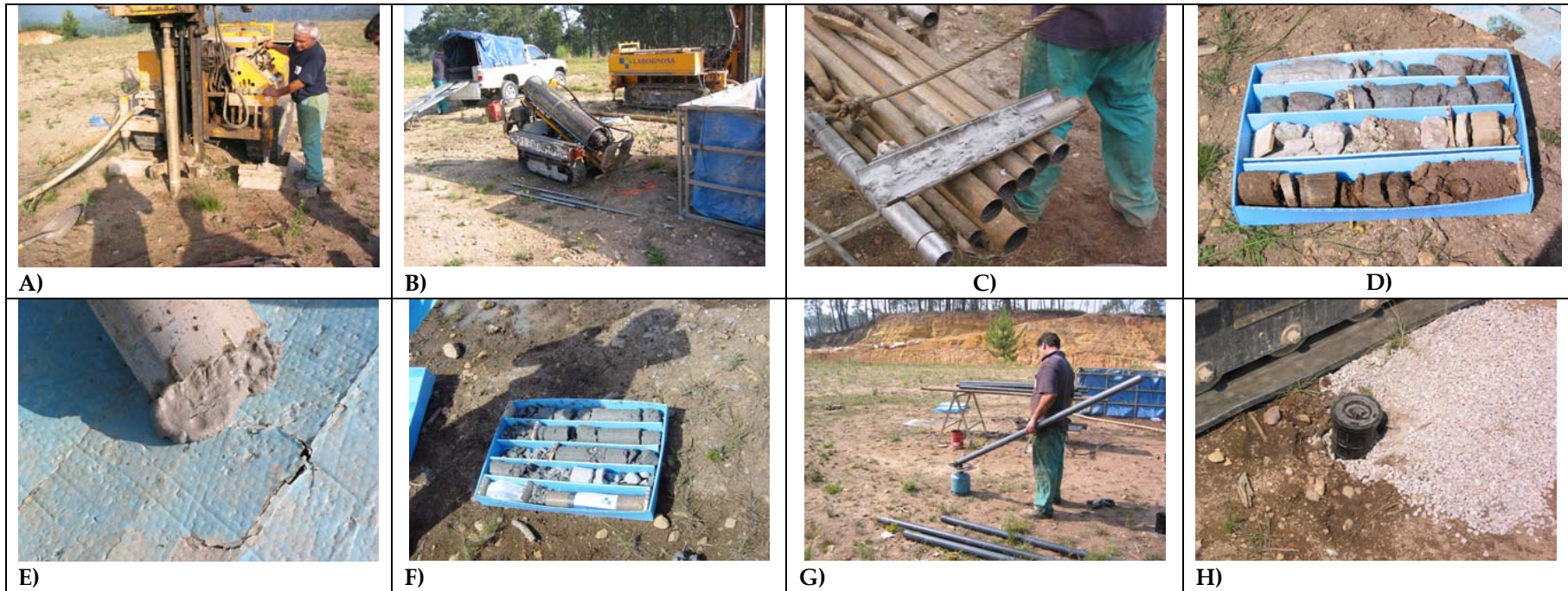
FIGURA 3.1. Imágenes tomadas a lo largo de la campaña de campo realizada sobre el relleno de O Cerquido (Porriño). A) Inicio de la perforación del primer sondeo con recuperación continua de testigo ( \phi = 110 mm; B) Máquina empleada en la realización de los ensayos penetrométricos tipo DPSH; C) Aspecto del tubo bipartido y de los serrines de granito contenidos dentro de él tras la realización de un ensayo de penetración tipo SPT; D) Caja de testigos de sondeo nº 1. Las dos primeras hileras (empezando por abajo) representan el recubrimiento de suelo vegetal localizado por encima del relleno de serrines; E) Detalle de la textura de los serrines de granito localizados a una profundidad inferior a 10 m. Las características del material (en particular su contenido de humedad) determinan su capacidad para fluir espontáneamente; F) Caja de testigos de sondeo en el que se localiza una muestra inalterada (tubo etiquetado en la parte inferior de la fotografía); G) Preparación del entubado ranurado de PVC emplazado en cada uno de los dos sondeos realizados; H) Aspecto final de la boquilla del sondeo y arqueta de registro (sin llave) emplazada in situ
