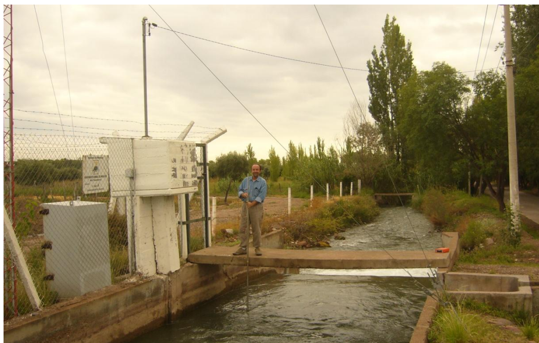
Figura 13 - Canal Naciente, con estación de aforo y sección telemétrica
