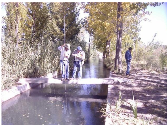
Figura 14 Canal Flores: sección óptima para la medición.
